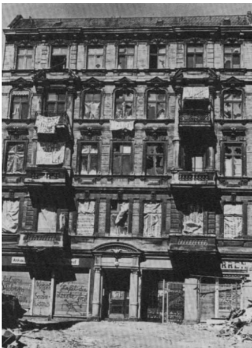
Instandbesetztes Haus Admiralstraße 15 in Kreuzberg (about 1981). Source: Internationalen Bauausstellung 1984: Selbsthilfe im Altbau (self-help in the old building). Berlin 1982, p 53. (SenStadt, 2010)
