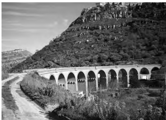
Fig. 15. Assoro (Enna). Ponte ferroviario.
