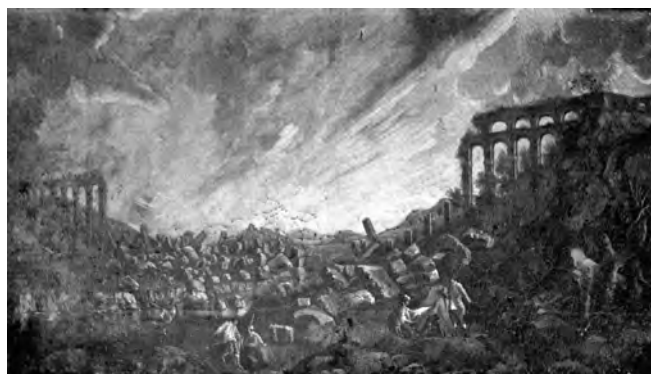
Fig. 5. Il ponte acquedotto di Aragona crollato dopo l'uragano del 1780 in un soprapporta di palazzo Biscari a Catania.
