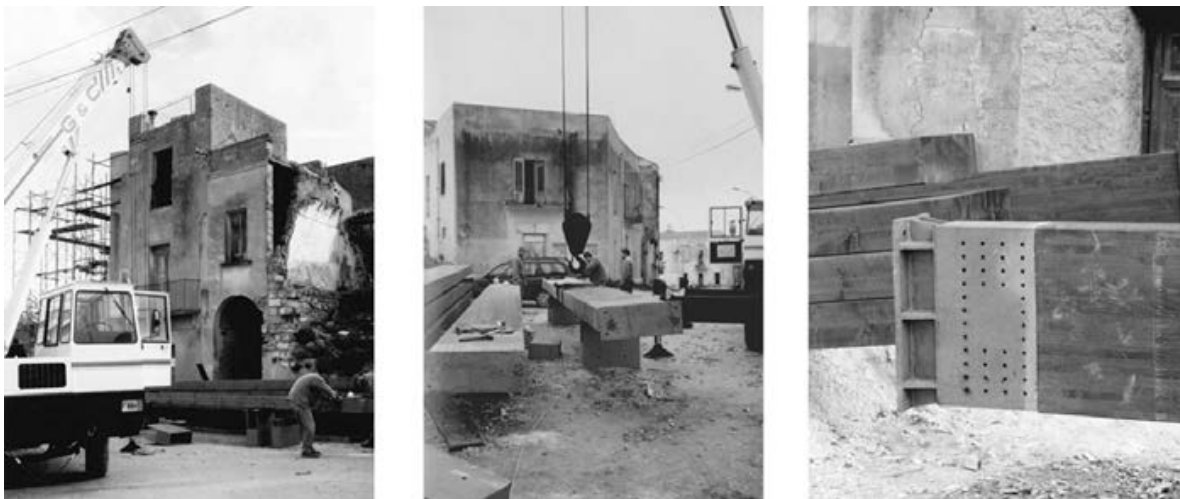
Figure 2-4. Immagini del cantiere di restauro, piloni di legno lamellare e particolare degli elementi metallici di connessione alle fondazioni
