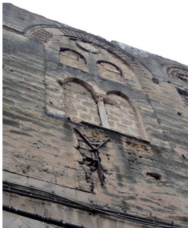
64. Palermo, convento del SS. Salvatore, particolare dei capichiave “a orecchie di lepre”.
