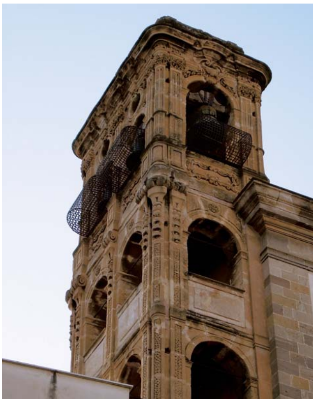
23. Palermo. Chiesa di Santa Chiara, campanile.
