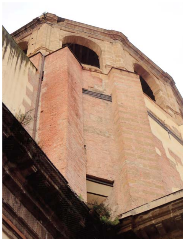
56. Palermo, chiesa del SS. Salvatore, cerchiature poste alla base della cupola.
