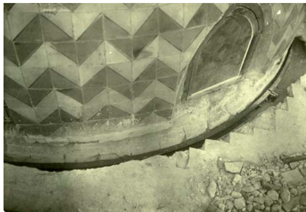
42. Palermo, palazzo Reale, cappella palatina, cerchiatura alla base della cupola (BCPa, Fondo Valenti, 5 Qq E 187 n. 1800076).
