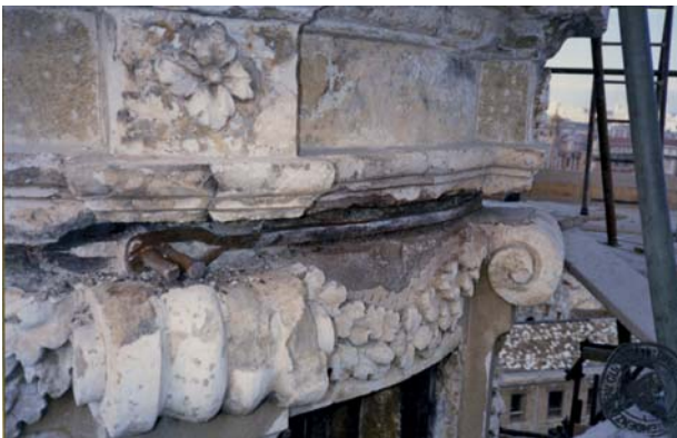
31. Palermo. Chiesa di Santa Caterina, cupola, particolare della cerchiatura in corrispondenza della lanterna (Soprintendenza Beni Culturali e Ambientali di Palermo, su concessione dell'Assessorato per i Beni culturali e l'Identità siciliana della Regione siciliana. Dipartimento regionale dei Beni culturali e l'Identità siciliana).
