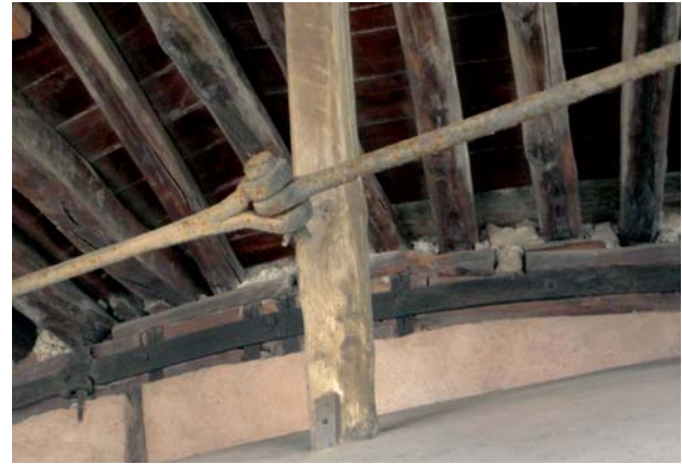
58. Palermo, chiesa del SS. Salvatore, particolare della cerchiatura posta in corrispondenza del cupolino della lanterna.
