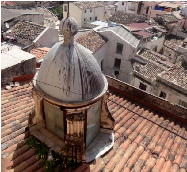
59. Palermo, chiesa del SS. Salvatore, cerchiatura posta in corrispondenza del cupolino della tribuna.
