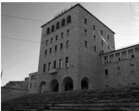
12. G. Bosio con I. Lambertini, Piano Regolatore Generale per la città di Tirana, 1939-1941 , particolare della sistemazione del viale dell'Impero e del piazzale del Littorio (ricostruzione grafica con le relazioni assiali di F. Malleo, 2012)
