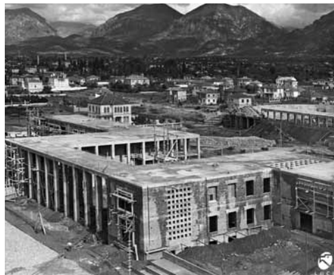
7. G. Bosio, Sede dell'Opera Dopolavoro Albanese (O.D.A.), Tirana, 1939-40, fasi dei lavori di costruzione, foto d'epoca (Roma, Istituto Luce, Occupazione italiana dell'Albania)
