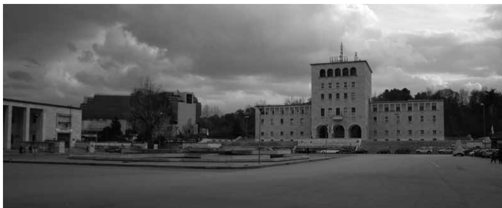
1. Gherardo Bosio con Ferdinando Poggi e Ferrante Orzali, Casa del Fascio (oggi sede dell'Università degli Studi), Tirana, 1939-1940 (foto E. Sessa, 2011)
