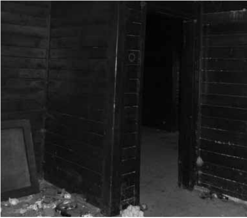
11. Albergo di caccia, riserva statale di Alessio, 1940, particolare del rivestimento ligneo originario di una camera (foto F. Dragusha, 2011)
