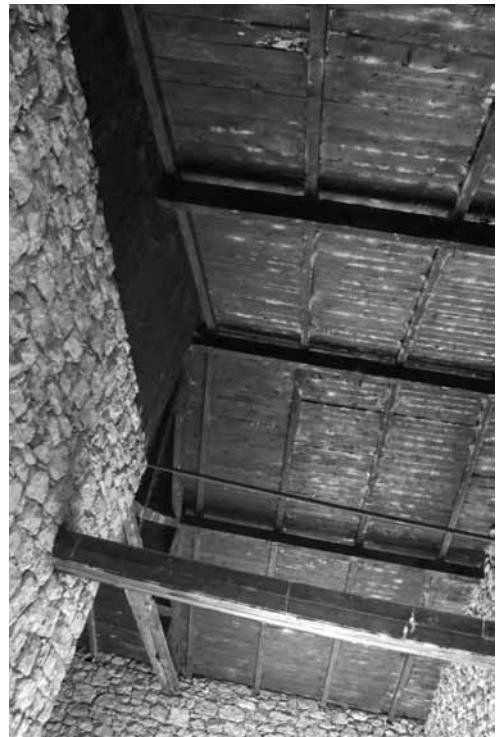
1. Albergo di caccia, riserva statale di Alessio, 1940, particolare del soffitto (foto F. Dragusha, 2011)
