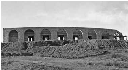
7. C. Valle, Convitto femminile, Tirana , 1940-43 ca., fasi dei lavori di costruzione, foto d'epoca (Roma, Istituto Luce, Occupazione italiana dell'Albania)
