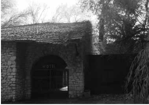
9. Albergo di caccia, riserva statale di Alessio, 1940, veduta dell'ingresso principale dopo l'intervento del 1985 (foto F. Dragusha, 2011)
