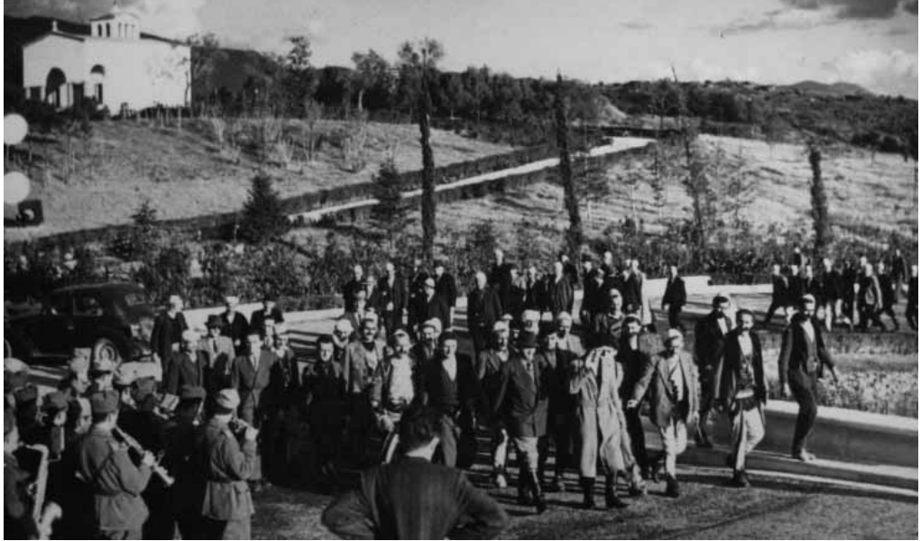
12. Villa Reale, poi Luogotenenziale (oggi palazzo delle Brigate), Tirana, cerimoniale nella villa, con prospettiva sulla cappella, foto d'epoca del 1942 (Tirana, Arkivi i Shtetit Shqiptar)
