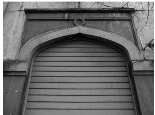
9. L'ex edificio delle Generali, Tirana, particolare decorativo (foto degli autori, 2011)
