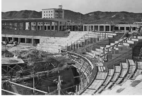
13. Stadio olimpico e Casa del Fascio (oggi sede dell'Università degli Studi), 1939-40, fasi dei lavori di costruzione, foto d'epoca (Roma, Istituto Luce, Occupazione italiana dell'Albania)
