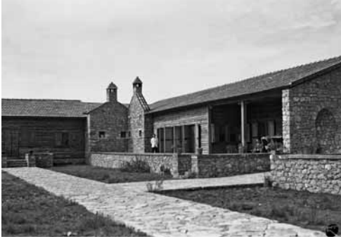
5. Albergo di caccia, riserva statale di Alessio, 1940, veduta della corte interna, foto d'epoca (Roma, Istituto Luce, Occupazione italiana dell'Albania)
