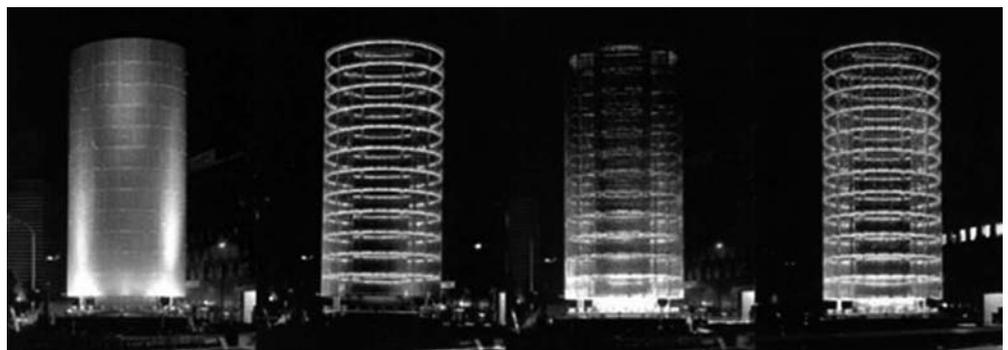
■ 6. La *Torre dei Venti* di Toyo Ito a Yokohama-shu-Kanagawa, 1986. Due computer posti alla base della struttura, registrano l'intensità e la variazione del vento, della luce, della temperatura e del rumore del traffico e trasmettono gli impulsi a 1280 lampade disposte sull'involucro della torre, costituito da un cilindro di alluminio forato circondato da dodici anelli al neon.
