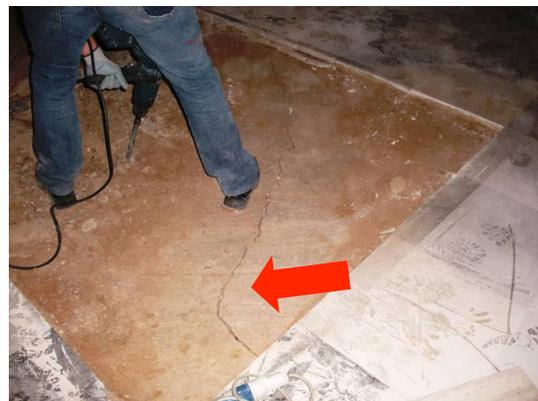
Foto 18: Fessura nascosta dalla pavimentazione
