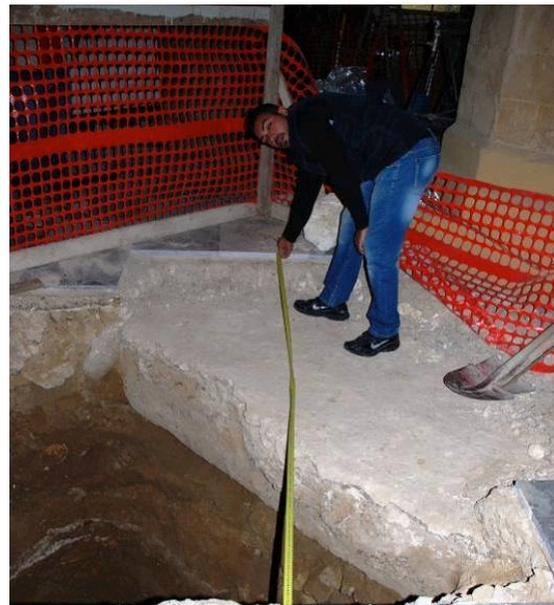
Foto 21: Opere di consolidamento delle fondazioni mediante reticolo di travi in c.a. e micropali
