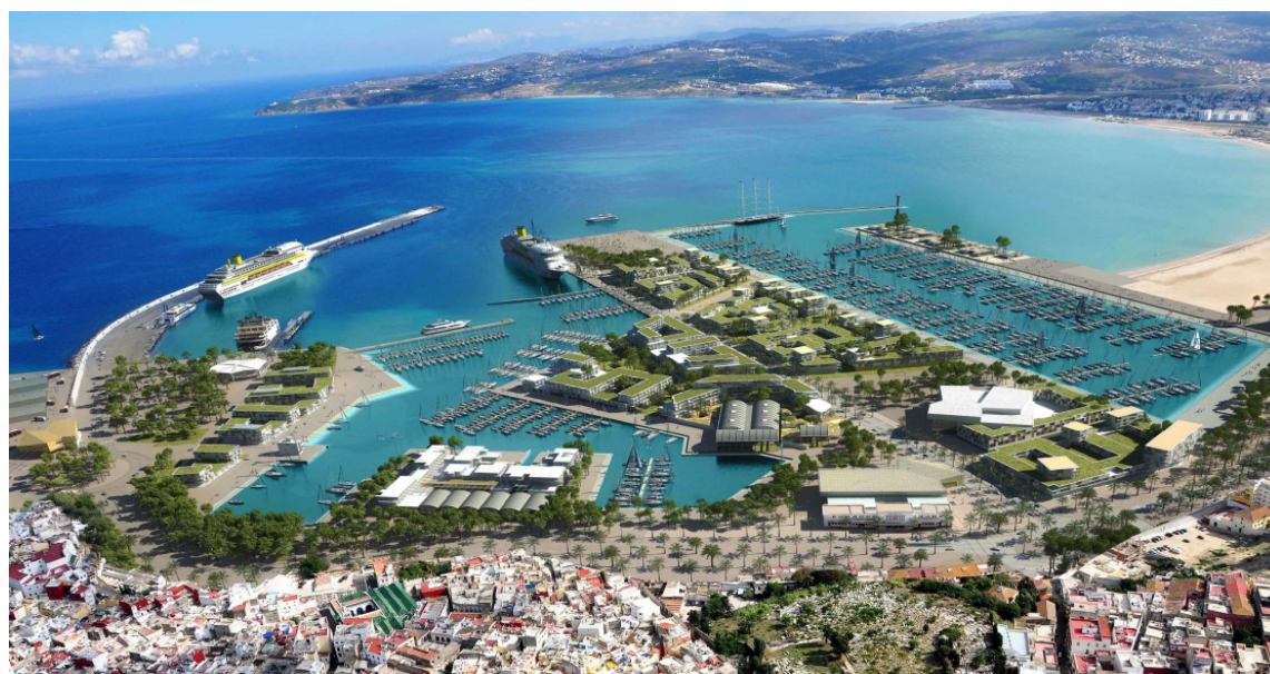
4 - Vista aerea del progetto di Norman Foster, Reichen & Robert. In primo piano i due bacini per il diporto e la zona franca convertita ad area di ricezione turistica (© SATP Société d' Aménagement Tanger Port).
