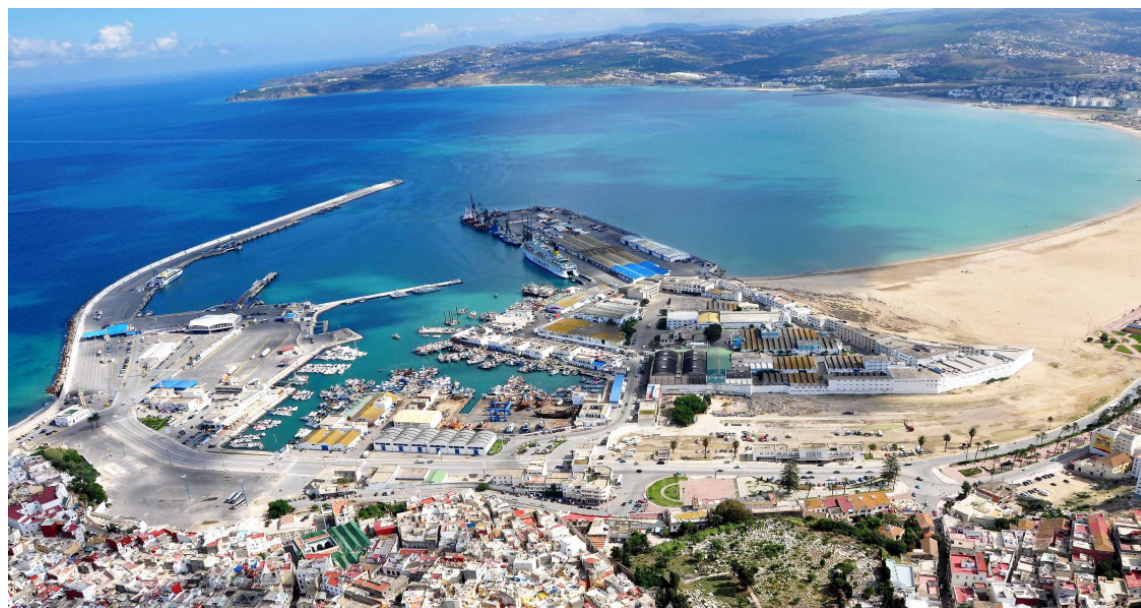
3 - Vista aerea dello stato di fatto. In primo piano la darsena del porto peschereccio e la zona franca adibita a stoccaggio delle merci (© SATP Société d' Aménagement Tanger Port).
