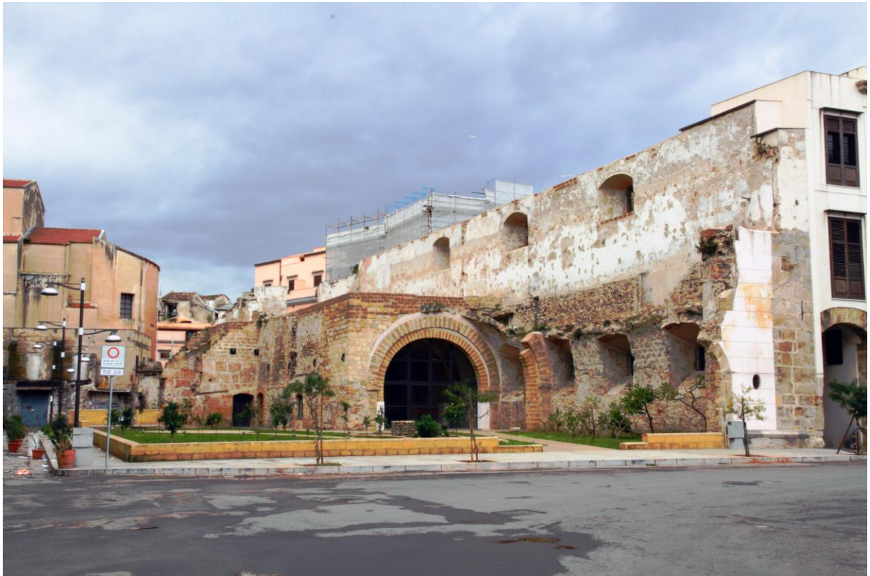
Fig. 4: Palermo, Piazza della Fonderia. E' stato da poco tempo ultimato il progetto della nuova piazza che costeggia il porto della Cala e che utilizza parte del volume e dei ruderi come sala per attività culturali.
