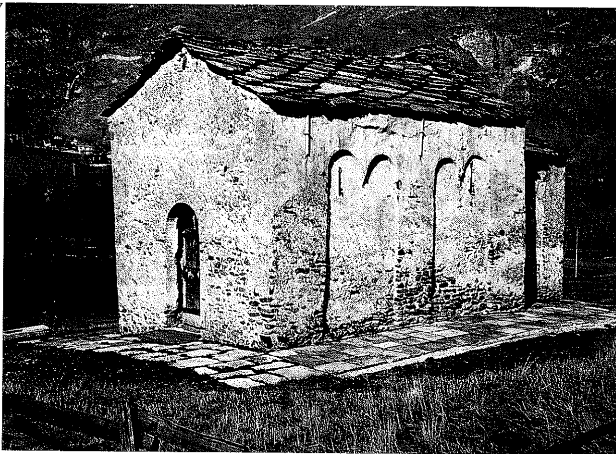
FIGURA 27 • Abbazia della Novalesa (Torino), cappella di Santa Maria, facciata e fianco meridionale dopo il restauro (1980). Si tratta d'uno dei migliori esempi di restauro d'intonaci, condotto con grande rigore teorico e sicure competenze tecniche. Scrive l'arch. L. Pittarello, responsabile della progettazione e direzione dei lavori, che una vera coscienza conservativa di tali testimonianze non è affatto diffusa e che, per operare correttamente, è necessario impegnarsi a fondo e progettare "il restauro degli intonaci con le stesse tecniche e attenzioni tipiche del restauro pittorico" (da "Bollettino d'Arte", suppl. 6, 1984).
