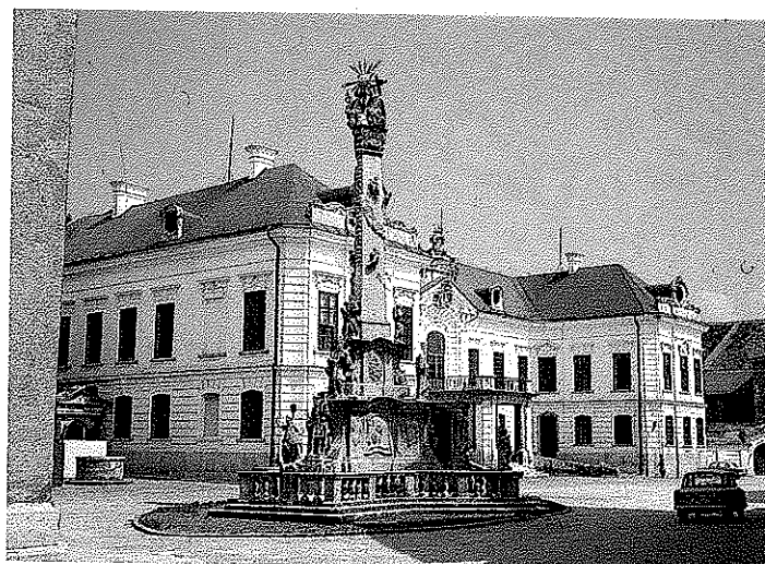
FIGURA 3 • Veszprém (Ungheria), palazzo Episcopale (arch. J. Fellner, 1765-76). Il confronto tra la vecchia facciata della figura precedente e quella ritinteggiata dell'episcopio mostra la pesantezza dell'intervento operato su quest'ultima e la decisa volontà innovativa che, sotto un'apparenza di conservazione, finisce col perdere ogni segno del tempo trascorso. La tecnica esecutiva potrebbe essere anche raffinata, ma il giudizio resterebbe uguale, trattandosi pur sempre d'un atto di sostituzione e di riproposizione al vero, non certo del trattamento che un edificio con due secoli di vita richiederebbe.
