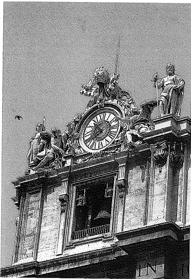
Figg. 15, 16 - Roma. Basilica di San Pietro in Vaticano. Si evidenziano alcuni particolari della facciata dopo il trattamento di pulitura diretto da Giuseppe Zander. L'intervento può essere considerato come una concreta interpretazione critico-conservativa. Infatti nella loggia centrale delle Benedizioni si possono vedere le tracce di colore lasciate dai tendaggi durante le funzioni presiedute dai pontefici nel tempo. La stessa superficie del travertino risulta risanata ma conserva quella patina che il tempo vi ha depositato.
