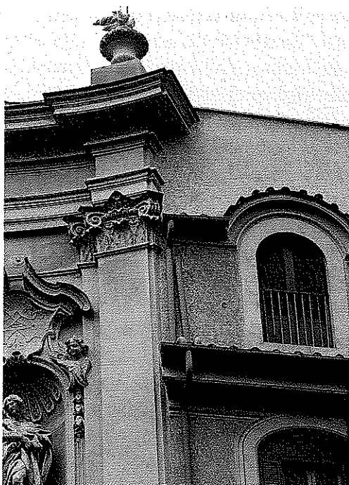
FIGURA 24 • Roma, chiesa della Maddalena, facciata (XVIII secolo), restauro delle superfici. La policromia sottolinea un simmetrico distacco, tra la facciata e i corpi di fabbrica collaterali, che non ha fondamento sicuro. Essa è inoltre resa con una tecnica puntinista che sta a dimostrare il disagio per la mancanza di quella vibrazione superficiale che solo gli antichi intonaci sanno dare; indica, in qualche modo, il tentativo di riprodurre anche i segni del tempo trascorso.
