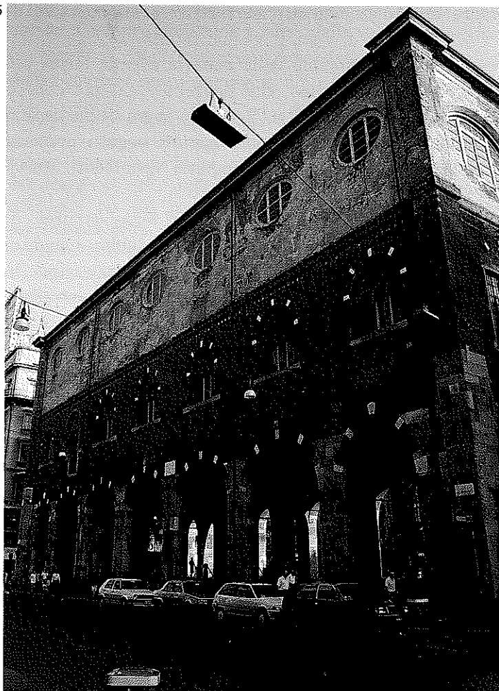
FIGURE 25-26 • Milano, palazzo della Ragione, prospetto principale (XIII e XVIII secolo), restauro (arch. M. Dezzi Bardeschi e A. Grimoldi). Tutto l'intervento ma, in specie, quello condotto sull'addizione settecentesca, nella parte alta dell'edificio, costituisce un modello del restauro come "pura conservazione", ed uno dei migliori esempi di trattamento delle superfici. Rispetto al Sant'Eligio in Roma, qui si rifiuta anche il rappezzo e si mantengono libere le zone dove l'intonaco è caduto, senza nulla sacrificare alla "leggenda dello strato di sacrificio" (G. Torraca). Il monumento, dopo il restauro, caso più unico che raro, serba intatta la sua carica evocativa, storica ed estetica.
