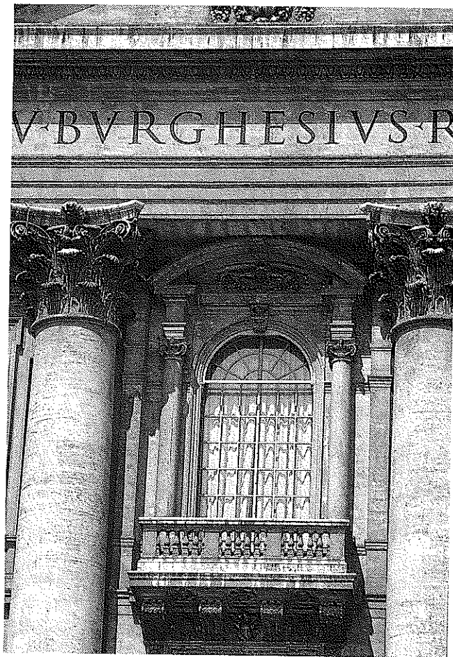
Figg. 15, 16 - Roma. Basilica di San Pietro in Vaticano. Si evidenziano alcuni particolari della facciata dopo il trattamento di pulitura diretto da Giuseppe Zander. L'intervento può essere considerato come una concreta interpretazione critico-conservativa. Infatti nella loggia centrale delle Benedizioni si possono vedere le tracce di colore lasciate dai tendaggi durante le funzioni presiedute dai pontefici nel tempo. La stessa superficie del travertino risulta risanata ma conserva quella patina che il tempo vi ha depositato.
