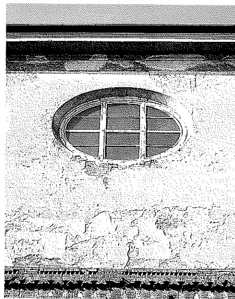
FIGURE 25-26 • Milano, palazzo della Ragione, prospetto principale (XIII e XVIII secolo), restauro (arch. M. Dezzi Bardeschi e A. Grimoldi). Tutto l'intervento ma, in specie, quello condotto sull'addizione settecentesca, nella parte alta dell'edificio, costituisce un modello del restauro come "pura conservazione", ed uno dei migliori esempi di trattamento delle superfici. Rispetto al Sant'Eligio in Roma, qui si rifiuta anche il rappezzo e si mantengono libere le zone dove l'intonaco è caduto, senza nulla sacrificare alla "leggenda dello strato di sacrificio" (G. Torraca). Il monumento, dopo il restauro, caso più unico che raro, serba intatta la sua carica evocativa, storica ed estetica.
