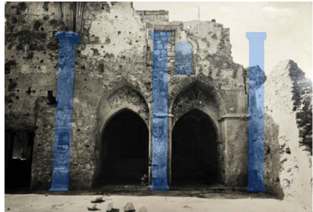
4. Cagliari. Chiesa di San Domenico, tracce riferibili alla copertura ad archi diaframma, post 1943 (su concessione della Soprintendenza BAPSAE per le province di Cagliari e Oristano).
