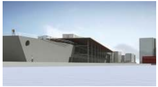
Le residenze sul molo di sopraflutto
