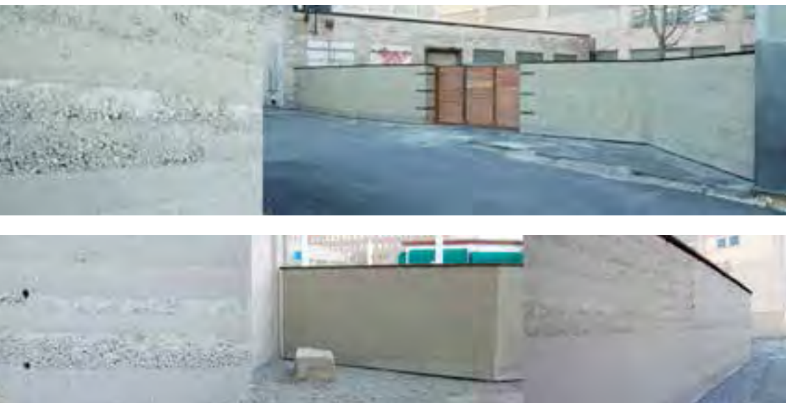
Figg. 17, 18 – Rammed Earth N51: il muro in terra battuta completato.
