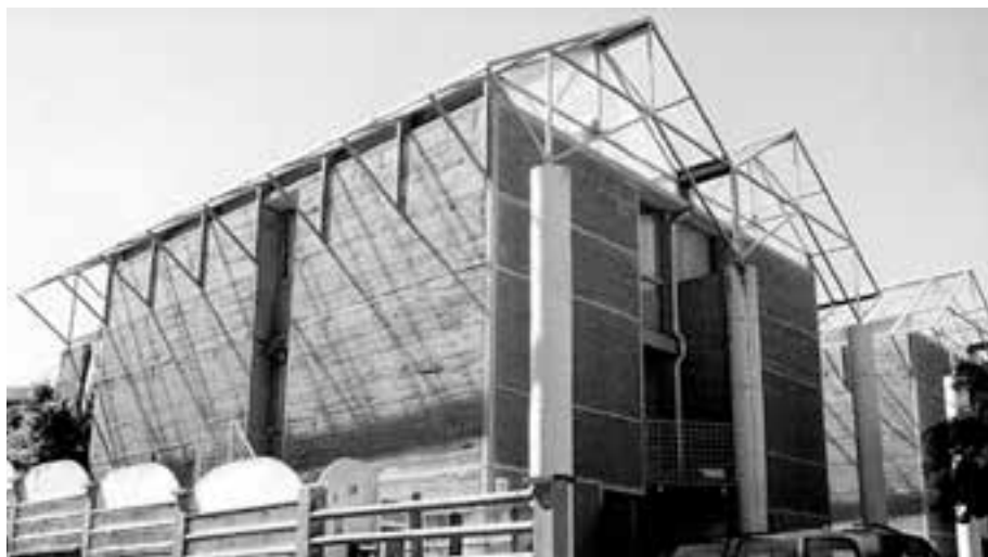
Fig. 2 – Uno degli edifici all'interno del quartiere Domaine de la terre , a Lione, progettato da Jourda & Perrandin.
