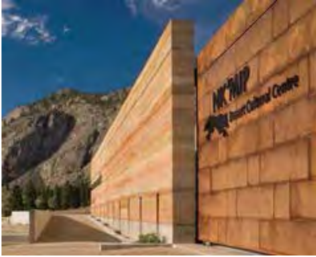
Fig. 10 – Il muro realizzato in pisé nel Centro Culturale NK'MIP in Canada.
