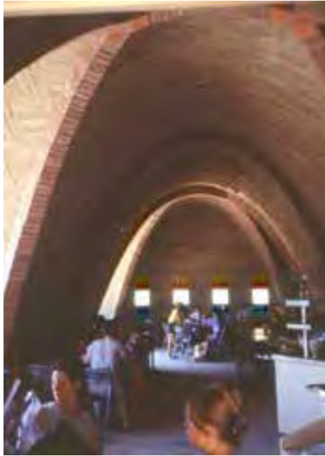
Fig. 3 – Il ristorante all'interno del Centro Ecologico Europeo Terre Vivante, realizzato in blocchi compressi di terra cruda.
