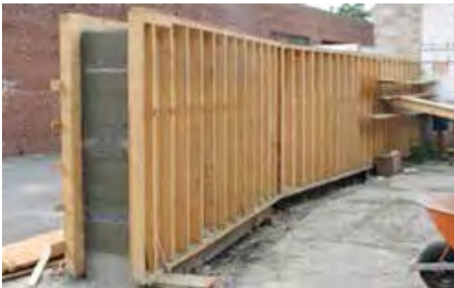
Fig. 16 – Rammed Earth N51 : la cassaforma del muro in terra battuta.
