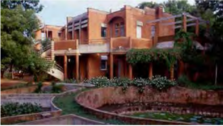
Fig. 7 – Abitazioni in blocchi compressi di terra cruda in India, arch. Satprem Maini.
