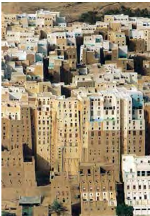
Fig. 1 – La città di Shibam nello Yemen (sec. XVI), costruita interamente in terra cruda.
