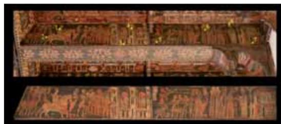
**Fig. 7** Punti di appoggio per il raddrizzamento e fotopiano della faccia verticale della trave IX rivolta verso la parete sud-ovest (vedi anche fig. 6).
