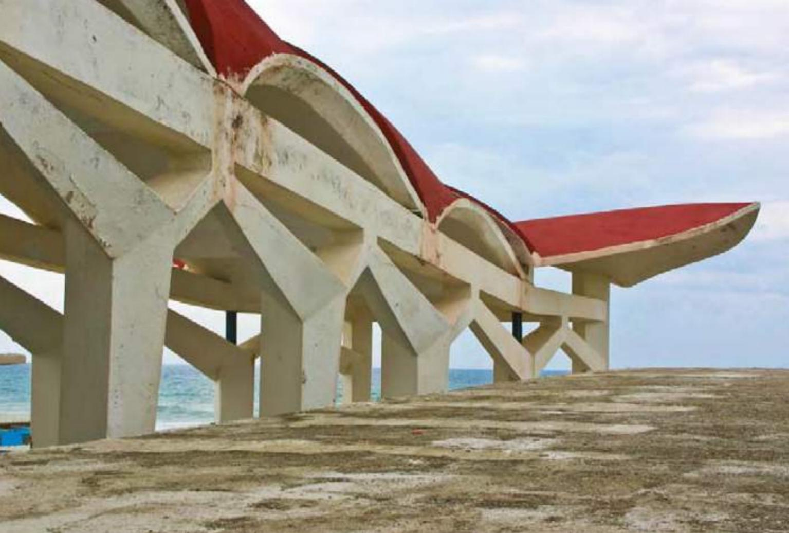
Lo studio delle volte di Mortelle dimostra che i gusci seguono una costruzione geometrica precisa e poco frequente: superfici ottenute per traslazione di un arco lungo due direttrici, una retta, sul lato mare, l'altra curva, verso la strada; una conoide particolare in cui la traslazione di una retta è sostituita da quella di una curva.
