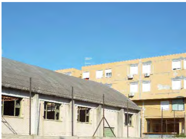
Fig. 150: I padiglioni industriali a nord dell'insula 3A.
