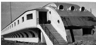
Fig. 3. Raccordo con il suolo e scala d'accesso al secondo livello dei dormitori nell'estremità verso monte (ACBV CPC)
