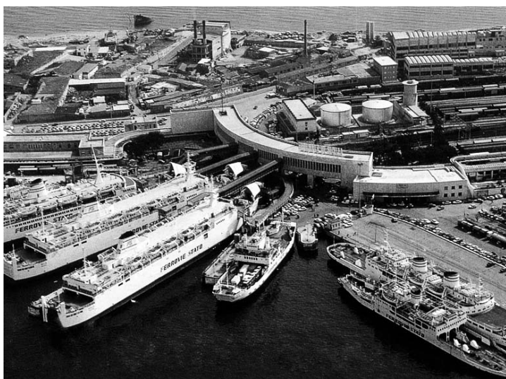
Fig. 10. MAZZONI A., Il complesso della Stazione marittima e centrale (1936-1939)
