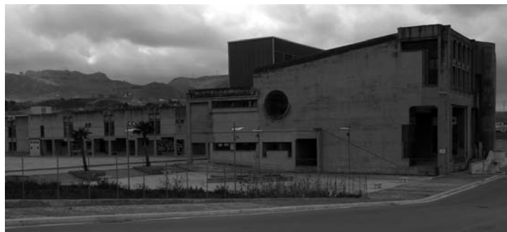
Fig. 1. Municipio di Gibellina. (Foto del 2008). La ricerca di una soluzione del dissidio tra "domestico" e "monumentale" costituisce il filo conduttore della progettazione del Municipio
