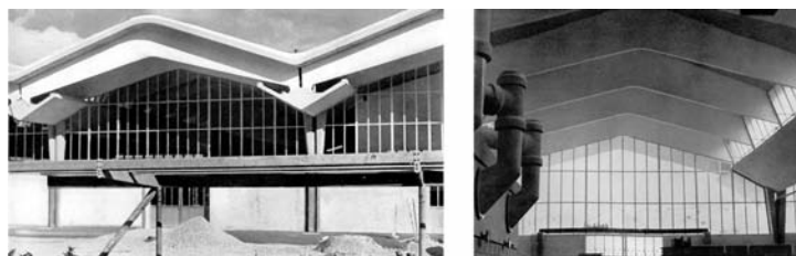
Fig. 2. Vista esterna ed interna di una campata dello stabilimento per la produzione di ceramiche (1957)
