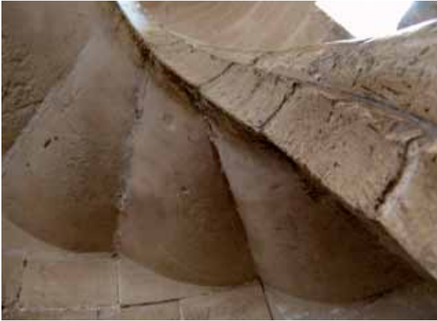
12-13. Modica. Chiesa di San Giorgio, vista dell'intradosso della scala e particolare della modanatura elicoidale semplice.
