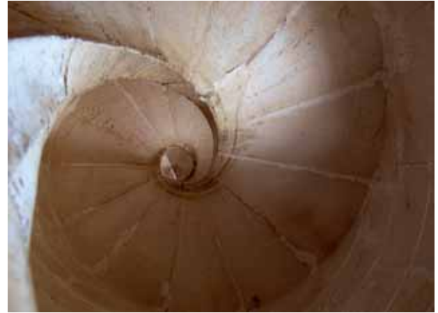
12-13. Modica. Chiesa di San Giorgio, vista dell'intradosso della scala e particolare della modanatura elicoidale semplice.
