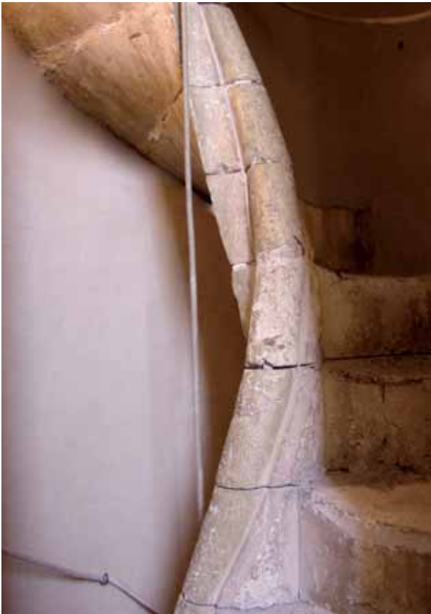
16. Noto. Chiesa di San Carlo, scala a chiocciola con occhio centrale con modanatura elicoidale articolata.
