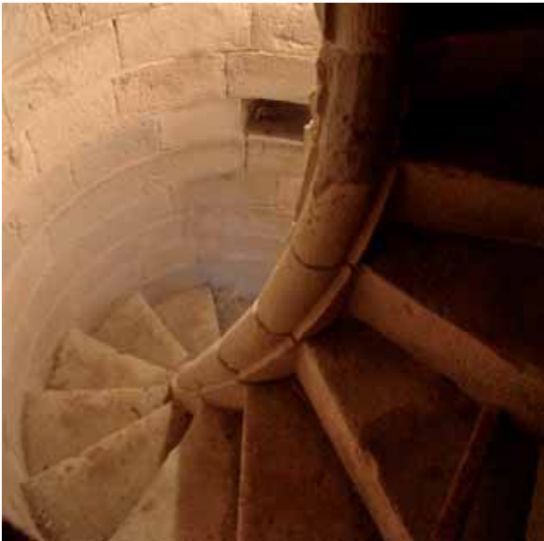
14. Monterosso. Chiesa di San Giovanni Battista, scala a chiocciola con occhio centrale e modanatura elicoidale semplice.
