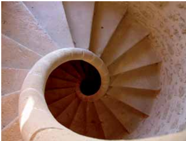
7. Castellammare del Golfo. Castello “Al Madarig”, scala con montante cilindrico.
