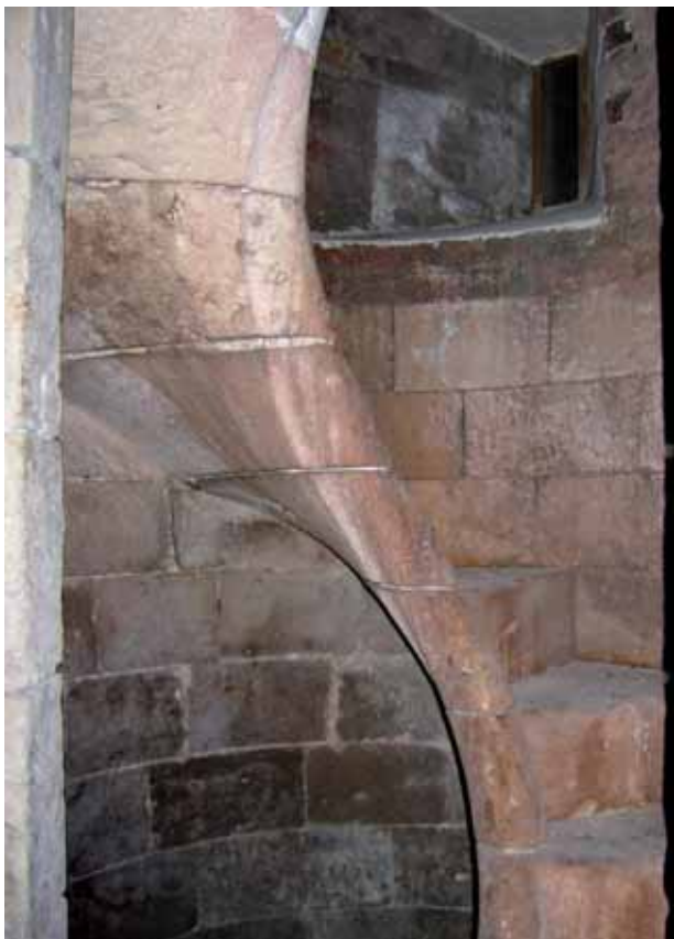
8. Siracusa. Palazzo Beneventano del Bosco, XV secolo?, scala elicoidale con occhio centrale (foto V. Belfiore).
