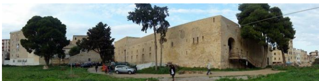
Fig. 4 Vista del Castello dall'area a SO
