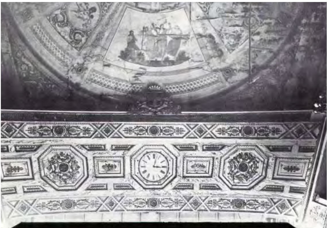
Intradosso dell'arco armonico e controsoffitto della sala. (primi anni del XX sec). ©Archivio storico comunale di Messina.
