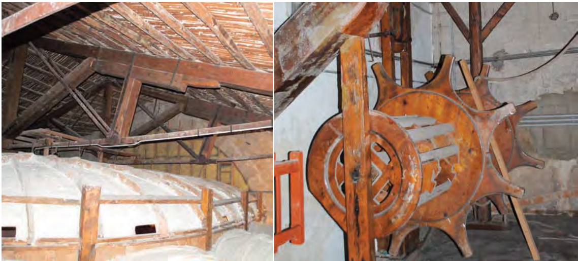
Fig. 19 - 20 - Estradosso del controsoffitto della sala e macchine da scena. Teatro del Popolo, Vittoria. ©Lo Sardo, P.
