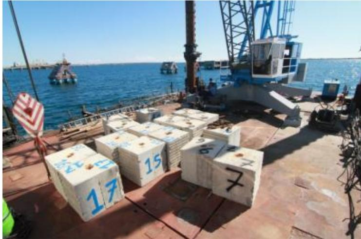
**Figura 3.35** – Fase di movimentazione dei provini con la piattaforma *self elevating* autopropulsa
