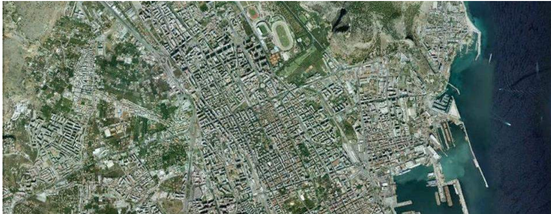
Fig. 4.9 - Vista aerea di Palermo e della zona di espansione a nord-ovest, già urbanizzata.
