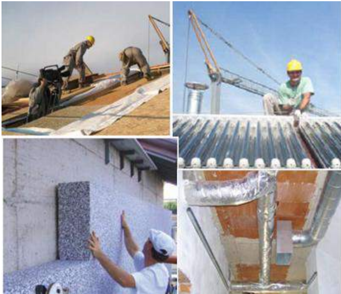
Fig. 3.21 – Interventi di retrofit energetico da parte delle aziende partner per il miglioramento delle prestazioni energetiche dell'involucro edilizio. © Fierabolzano.
