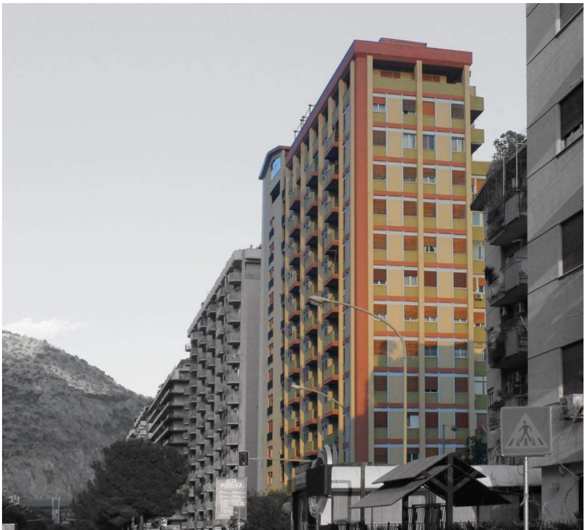
Fig. 4.11 - Vista d'angolo dell'immobile, tra la via Alcide De Gasperi e la via Empedocle Restivo. (2012).
