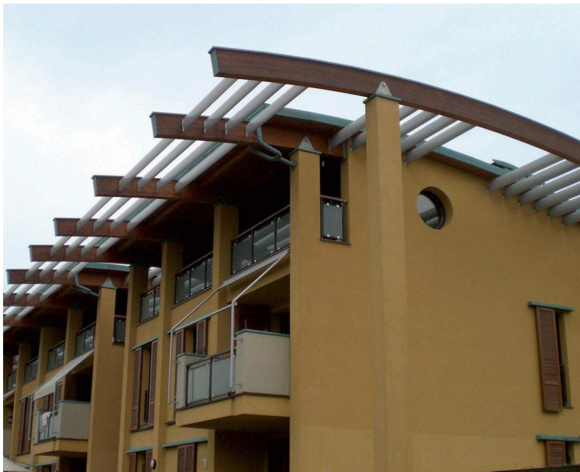
Fig. 5.14 - Edificio con lamelle frangisole dal profilo portante interno realizzato in alluminio estruso, dimensione 90x40 mm, con speciali agganci per l'aggraffaggio della lamiera. Parma 2012 © Sunbreak.
