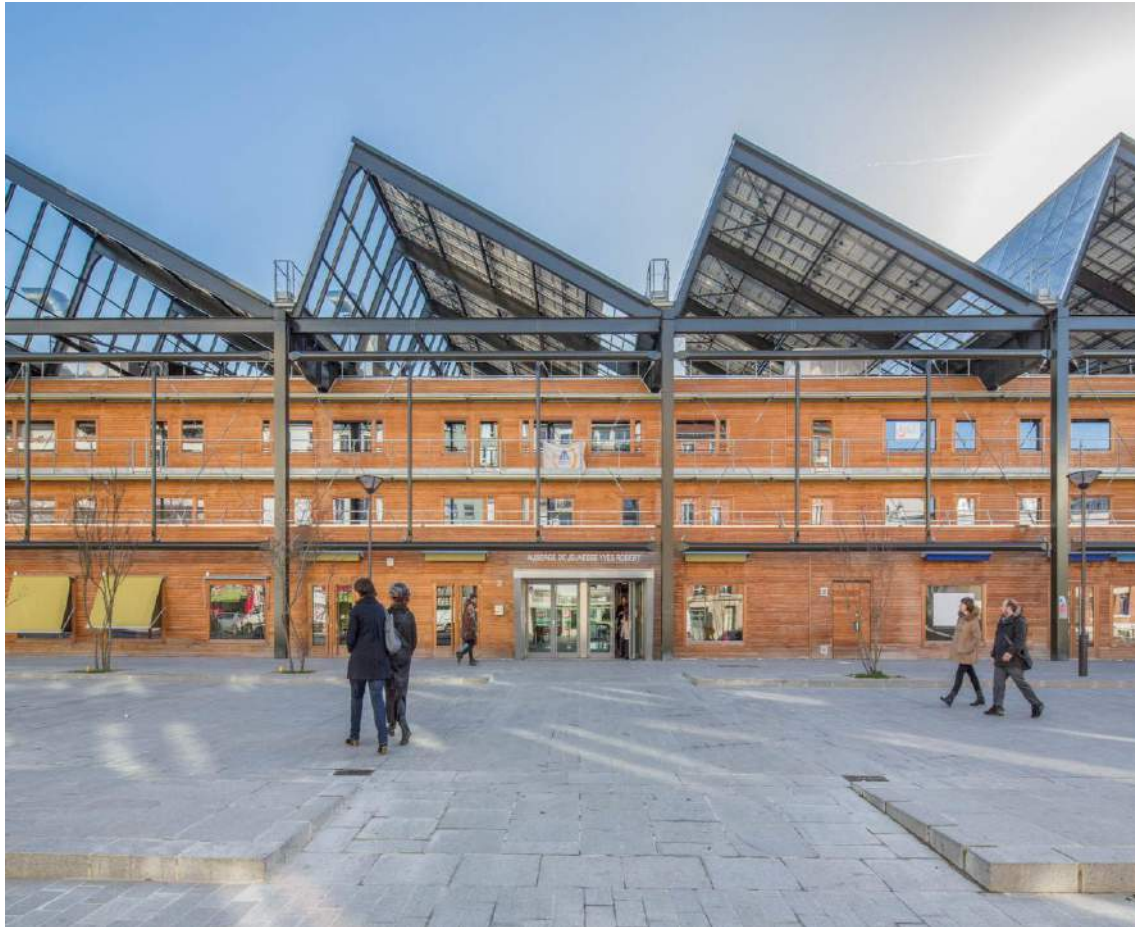
Fig. 3.8 - Prospetto in legno dell'edificio Hall Pajol di Parigi. I pannelli fotovoltaici ricoprono buona parte della copertura. ©Jourda Architectes.
