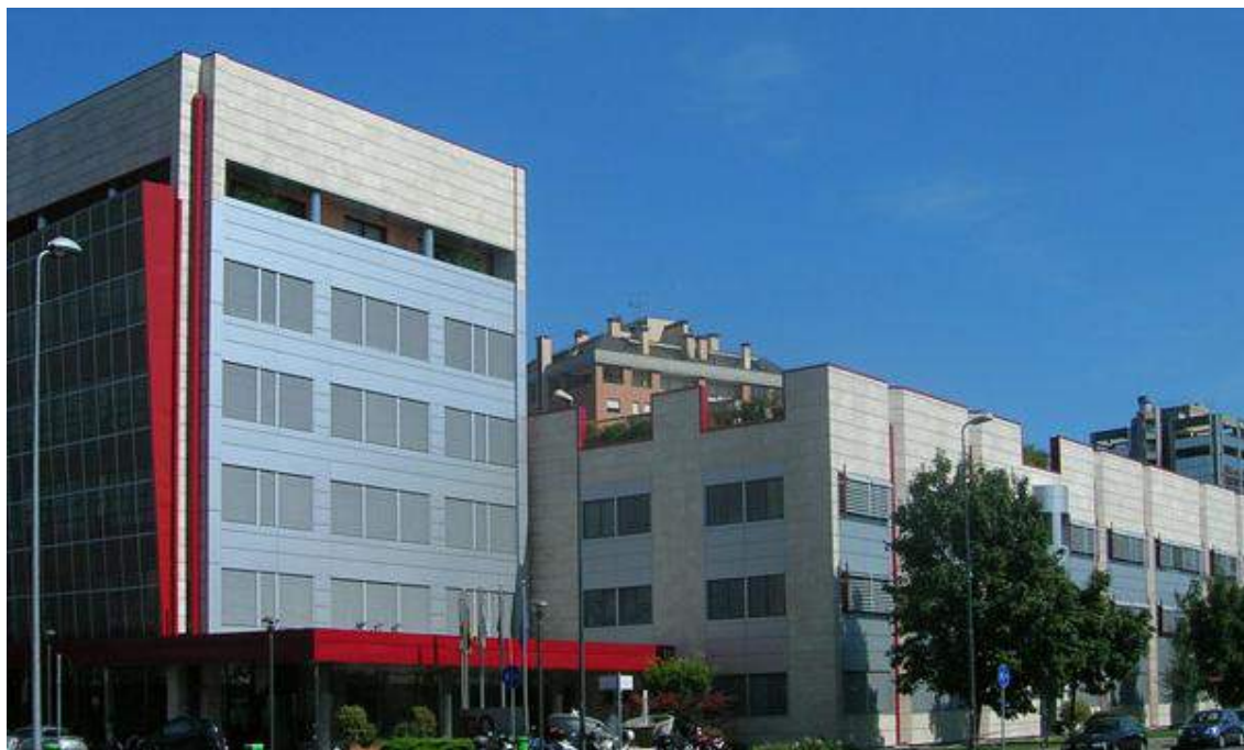
Figura 3.16 - L'edificio per uffici Ergo Tower di Via Pampuri a Milano, 2009 ©
