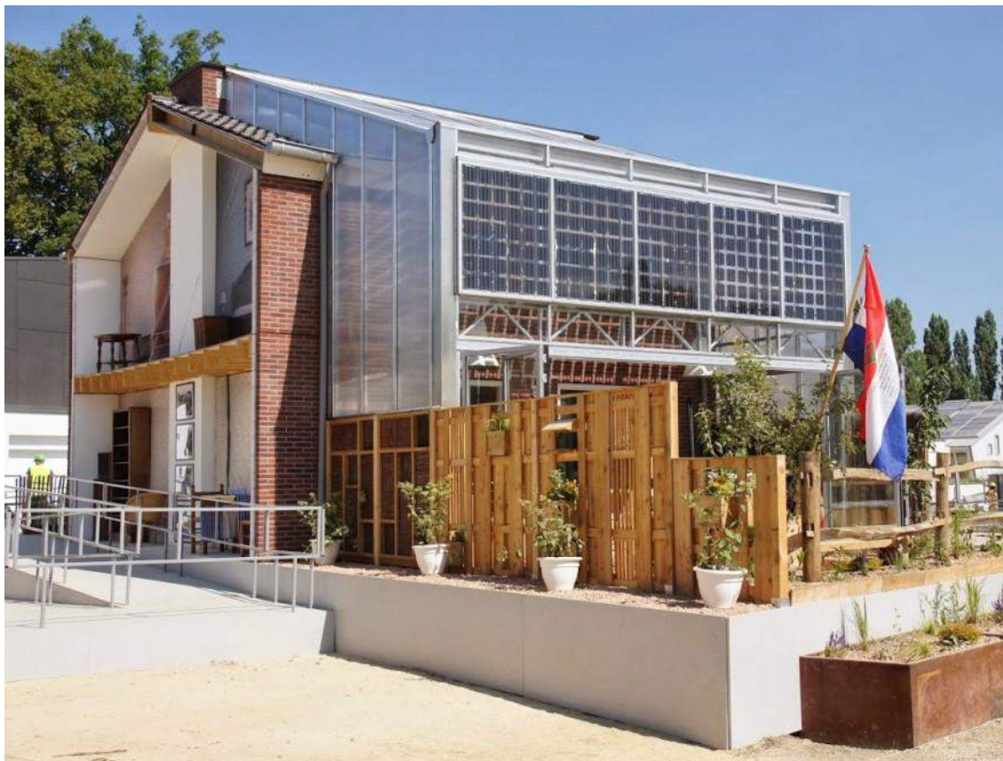
Fig. 3.13 – Vista della casa "Prêt-à-Loger" realizzata al Solar Decathlon Parigi 2014. © Pretaloger.nl
