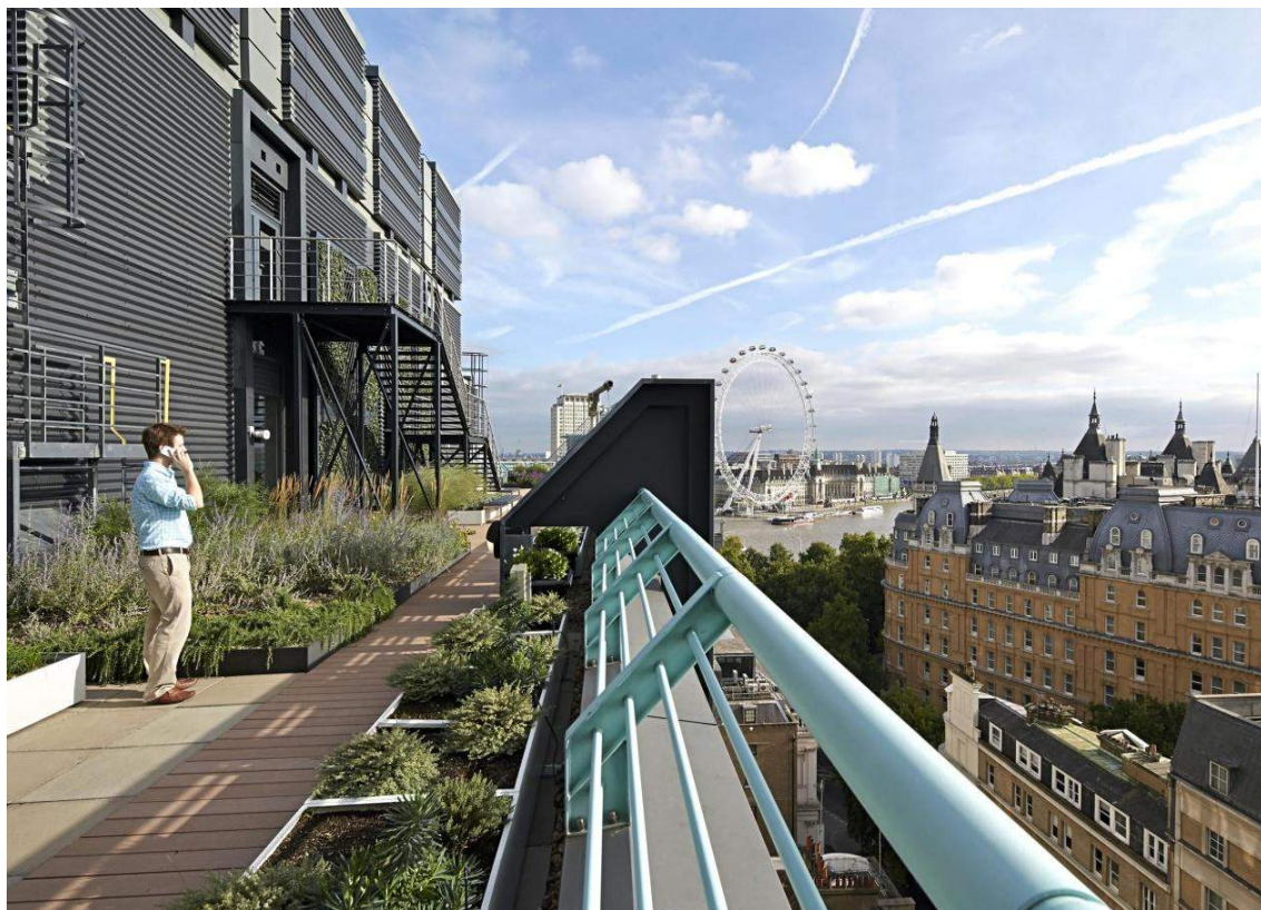
Fig. 3.4 - Vista della tetto giardino all'ultimo piano dell'One Embankment Place, Londra. © Hufton+Crow/PwC.
