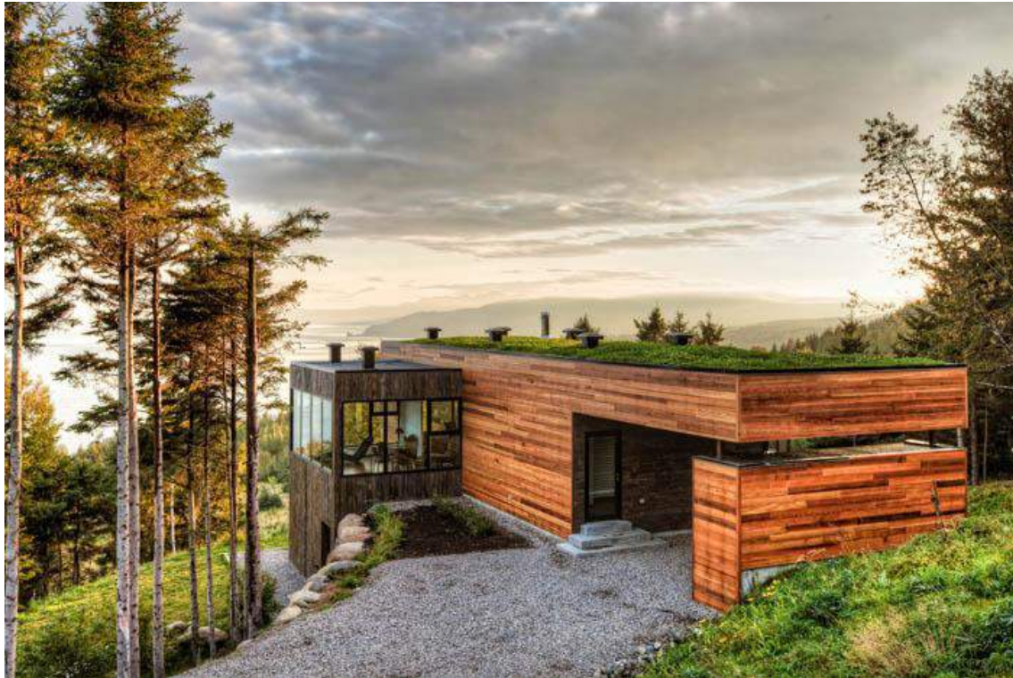
Fig. 5.11 - Casa Malbaie V- Le Phare progettata dallo studio MU Architecture, Quebec (2013). Il tetto della casa è coperto interamente da un tetto vegetale, rispondendo non solo ad esigenze di integrazione con il paesaggio, ma anche di isolamento, permettendo di ridurre l'accumulo di calore durante i mesi estivi. ©YUL Photo.
