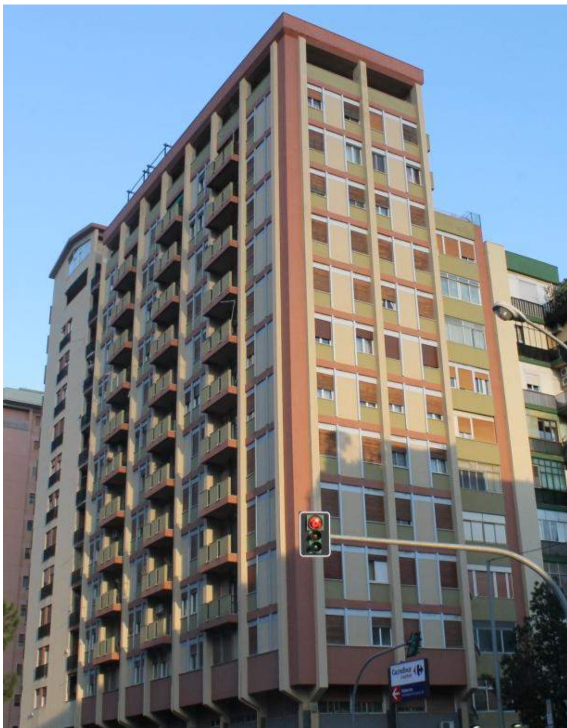
Fig. 4.14 - Foto dell'edificio con vista del prospetto esposto a sud-ovest (via Empedocle Restivo), e quello a nord-ovest (via Alcide De Gasperi).
