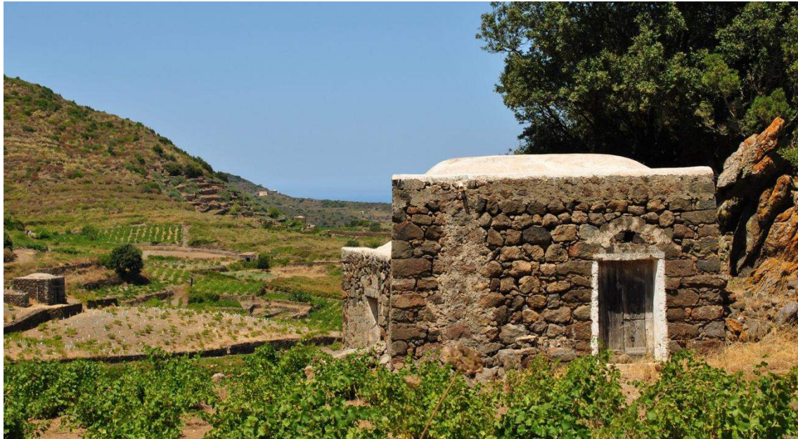
Fig. 5.6 - I dammusi di Pantelleria caratterizzati da un involucro di in pietra vulcanica di notevole spessore per proteggere gli ambienti interni dalla forte insolazione solare diurna.
