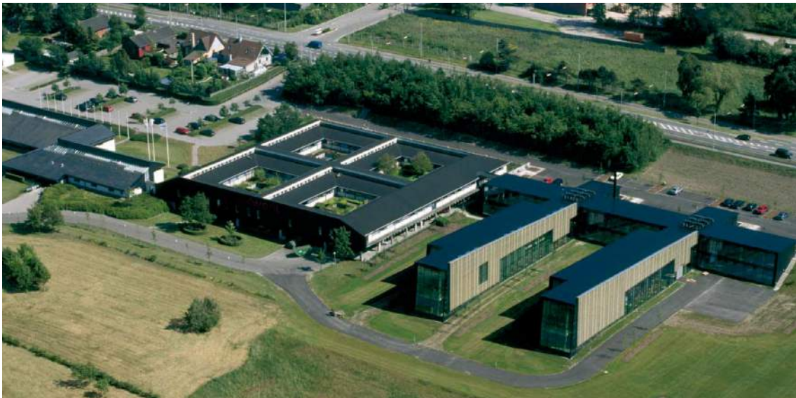
Fig. 3.2 - Vista del complesso degli edifici per uffici del "Building 2000", Centro di ricerca del Gruppo Rockwool in Danimarca © Rockwool
