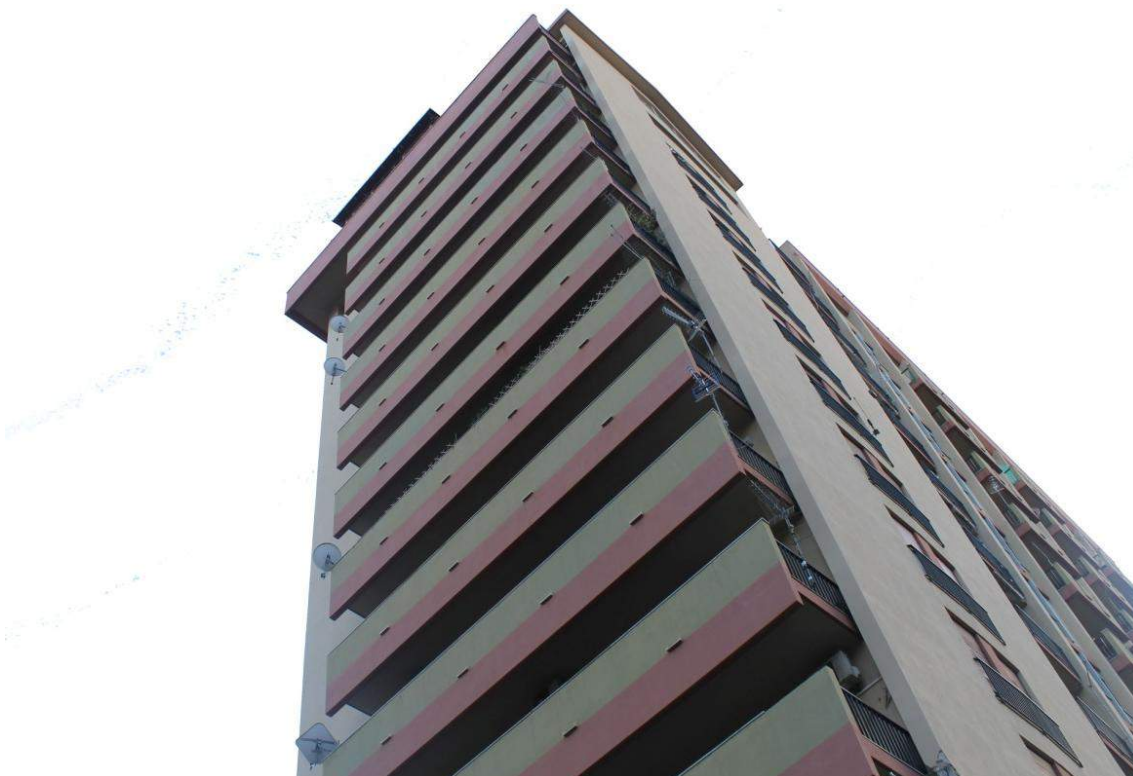
Fig. 4.13 - Foto dell'edificio con in primo piano il prospetto esposto a nord-est (2012).
