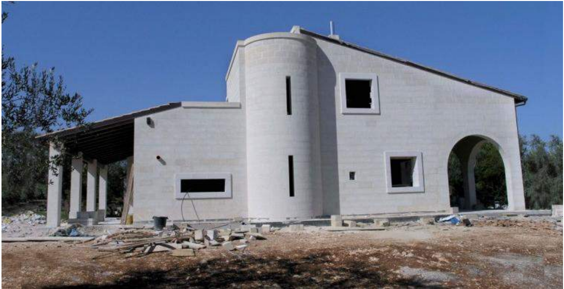
Fig. 3.22 - La Multi Comfort House a San Vito dei Normanni, Sicilia, durante i lavori di riqualificazione, in partnership con l'azienda Isover.
