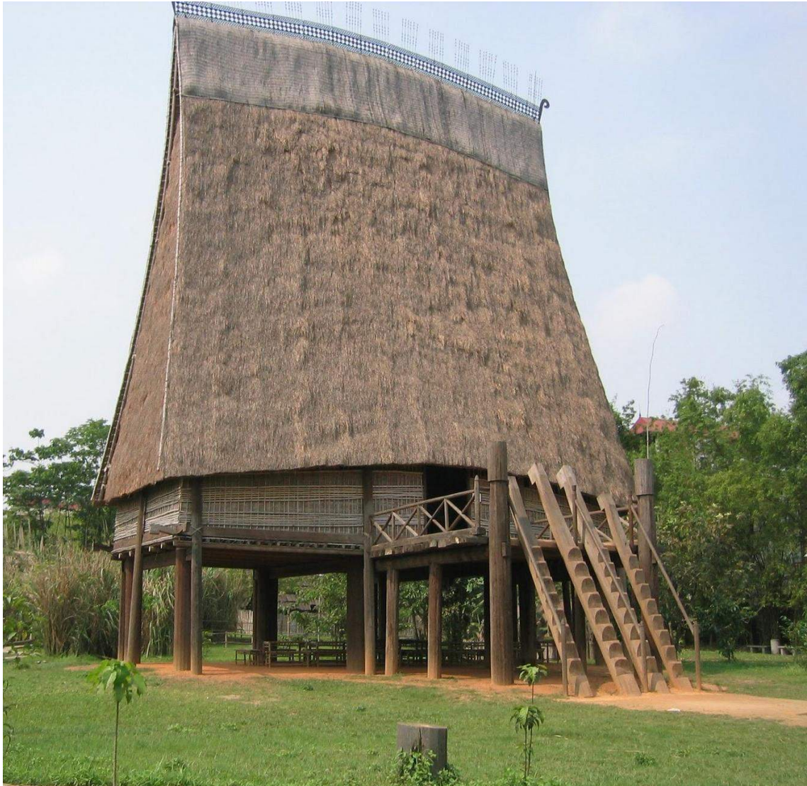
Fig. 5.7 - Bahnar Communal House ad Hanoi, Vietnam. Case tradizionali, costruite con corteccia e pannelli di bambù intrecciato o paglia, per massimizzare il vento fresco d'estate proteggendo l'interno dalla radiazione solare eccessiva.
