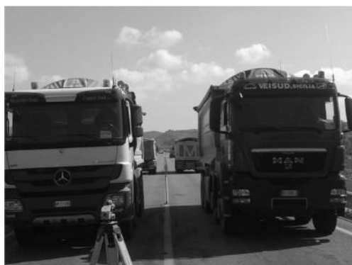
Figura 12 – Disposizione dei dumper nelle prove di carico
