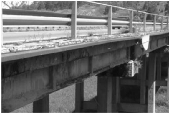
Figura 5 - Viadotto Ipsas III
