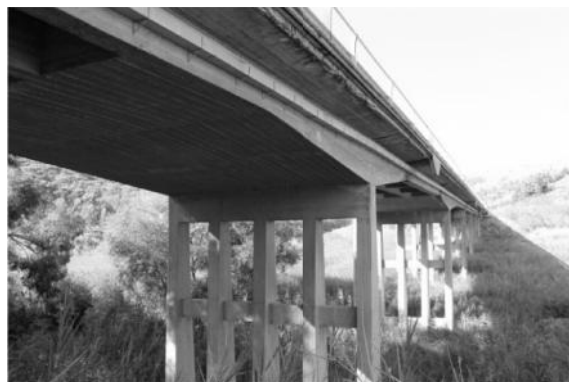
Figura 4 - Viadotto Ipsas II
