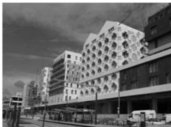
Figura 7– Nuova facciata dell'edificio Macdonald di fronte alla nuova linea del tram
