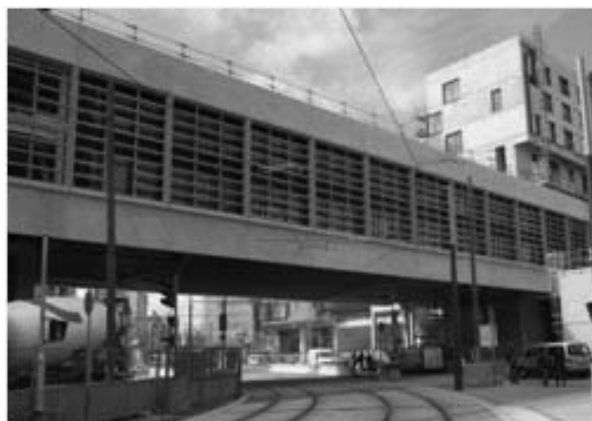
Figura 8– La nuova linea del tram attraversa l'isolato Macdonald
