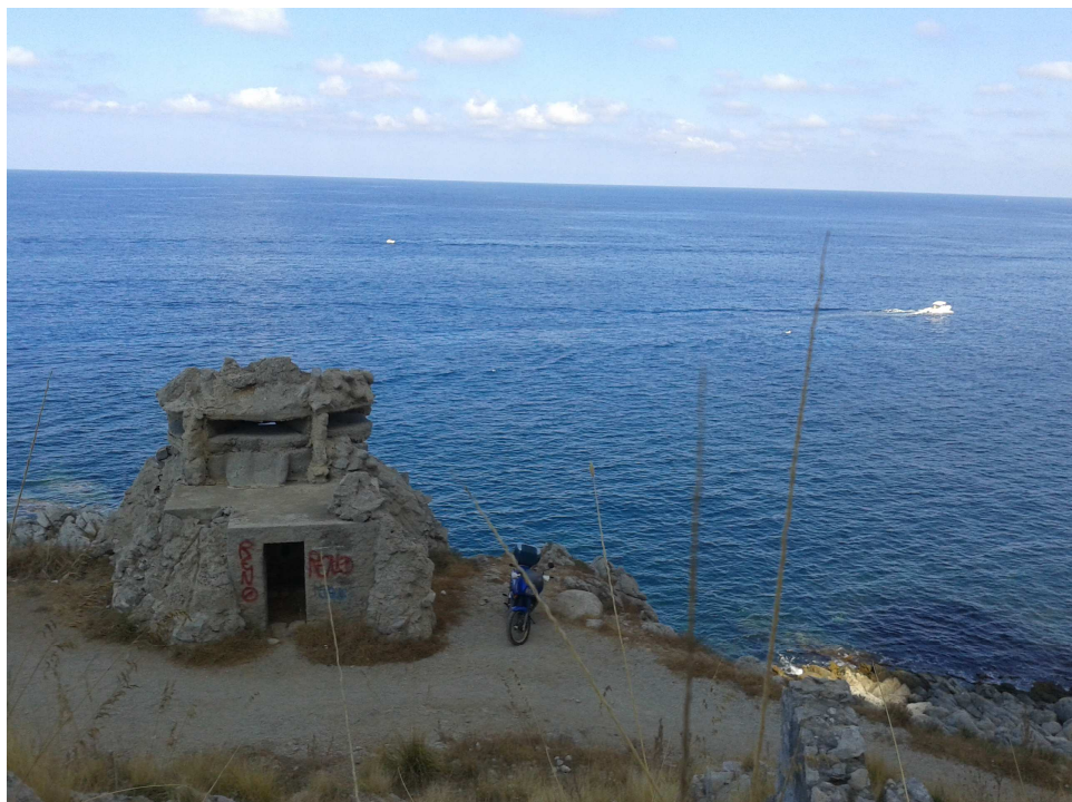
Fotografia 24 – Struttura abbandonata, pressi sentiero Marinella Faro, versante ingresso Mondello, 08.08.2014, h. 16.18
