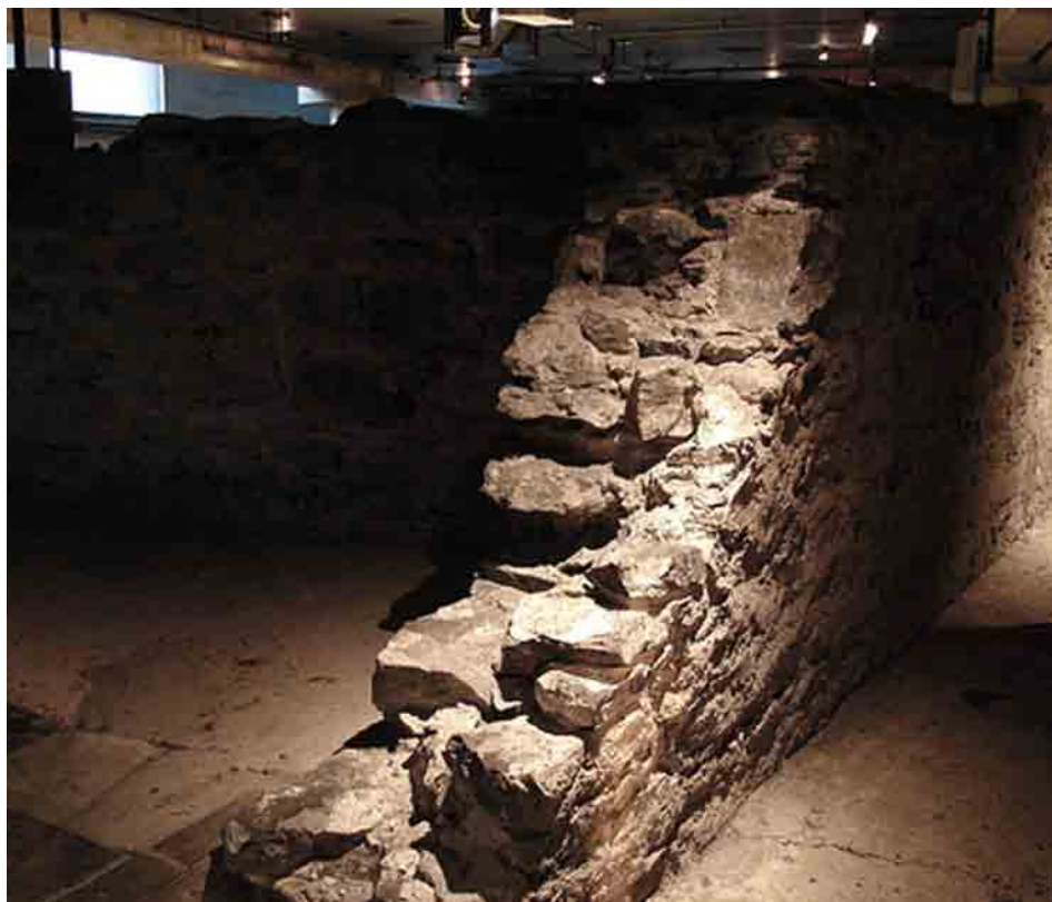
Fig. 5.62 Particolare di un muro del sec. XVII, all'interno della cripta.
