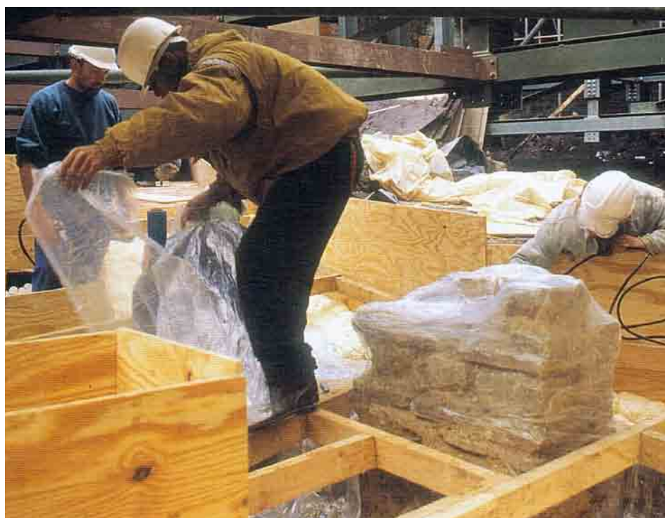
Fig. 5.45 Sistemi di salvaguardia delle vestigie rivestite con teli di polietilene e protette con casseforme di legno.
