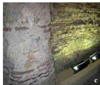
Fig. 5.32 Collezioni romane (a,b) e particolare degli impianti d'illuminazione (c), nella sala del frigidarium .
