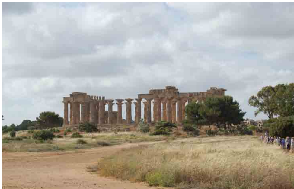
Fig. 4.20 Collina Orientale. Veduta del Tempio E.
