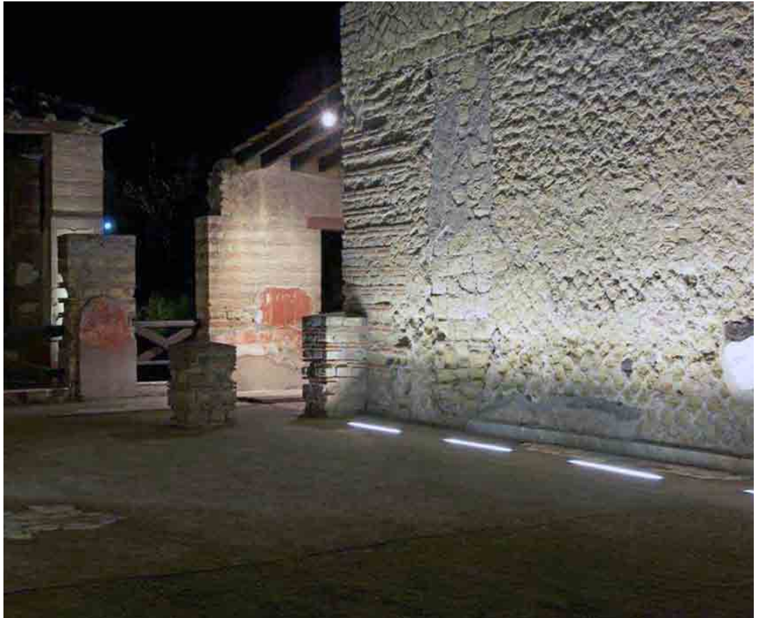
Fig. 4.47 Casa dei Cervi: impianto d'illuminazione esterno.
