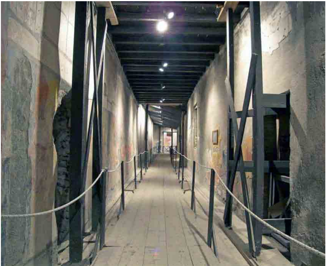
Fig. 4.48 Casa dei Cervi: pedana di legno montata sul corridoio, per proteggere i resti del- l'abitazione.
