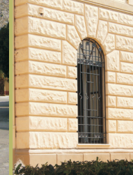
Particolari Palazzina Comando
