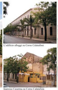
Ingresso Caserma su Corso Calatàfimi
