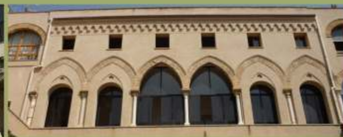
Prospetta via Nord dal primo piano nella corte interna
