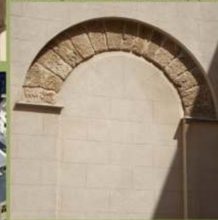
Fianco retrostante sulla corte interna
