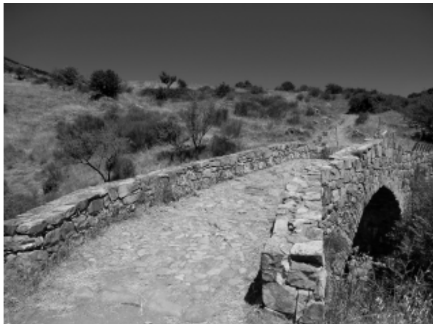
La pietra di Petralia. Ponte S. Brancato tra Petralia Sottana e Isnello.
