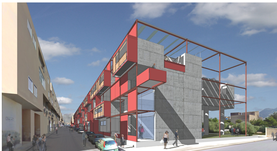
4. Vista della via Learco Guerra. Nuove residenze fra ZEN 2 (a sinistra) e cortile Gnazziddi (a destra). Una struttura leggera filtra il rapporto esterno-interno sul lato sud ed ospita sul tetto dei pannelli solari.
