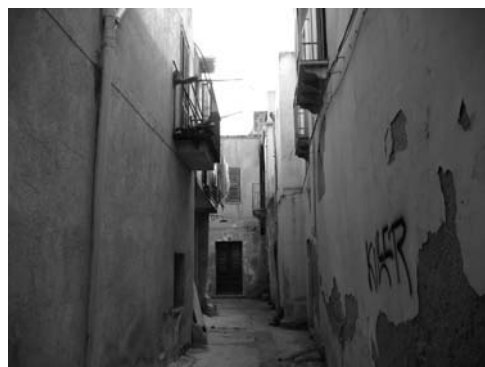
Figura 4.2 Fenomeni di degrado nella parte del centro storico abitata dalla comunità maghrebina.
