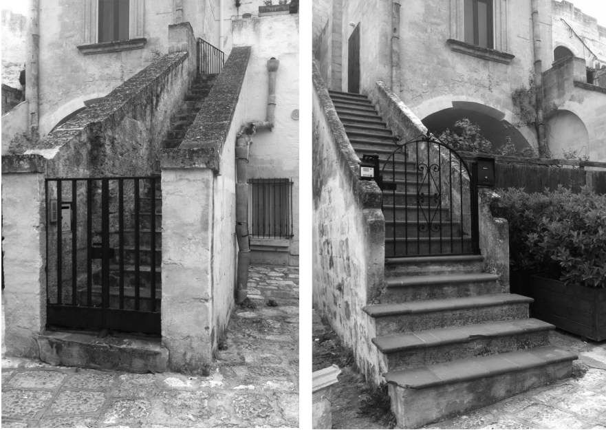
Figure 4. Matera, due alterazioni delle scale di accesso alle abitazioni. I cancelli che negano la permeabilità urbana che a nascere queste scale, di fatto negano il senso del luogo, pur avendo, probabilmente sottratto gli edifici al deterioramento del tempo.
