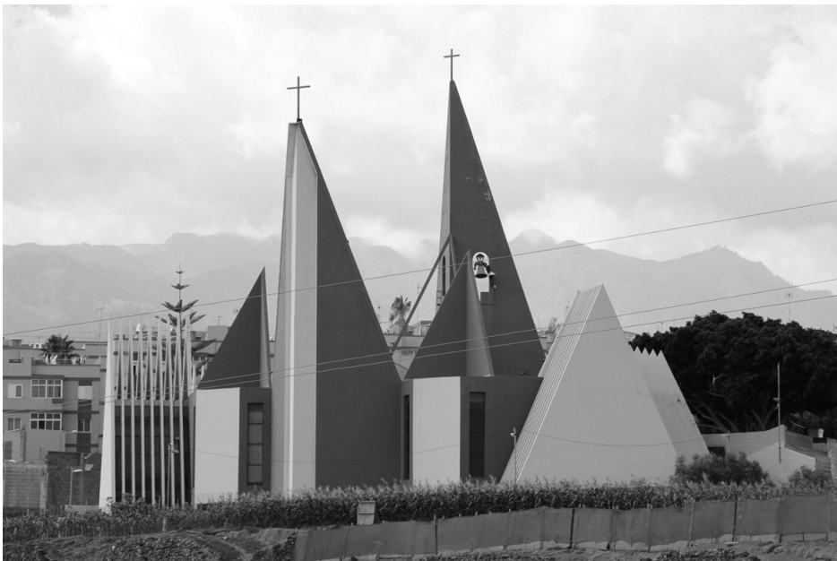
Figura 1. Iglesia de construcción actual en el municipio de Telde.
