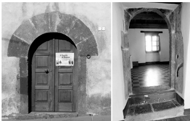
Figura 6. Il portale d'ingresso della casa Attene sulla piazza Santa Croce (a sinistra) e il dettaglio degli stipiti del portale che si ipotizza conducesse in passato direttamente al cortile tramite un loggiato.
