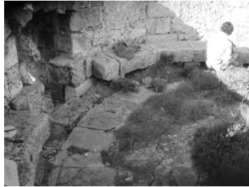
Figura 5. Vista de la reconstrucción del banco perimetral de la terraza superior de la Torre de Cala Teulera (A. Seguí)
