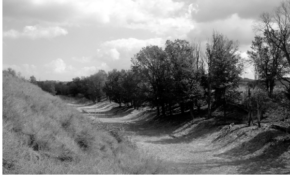
Figura 2. Cauce seco del Real Canal. Septiembre de 2009. Foto del autor.
