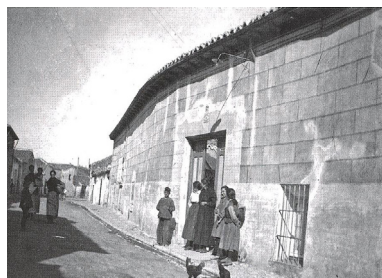
Figura 5. Recuperación de revocos.
