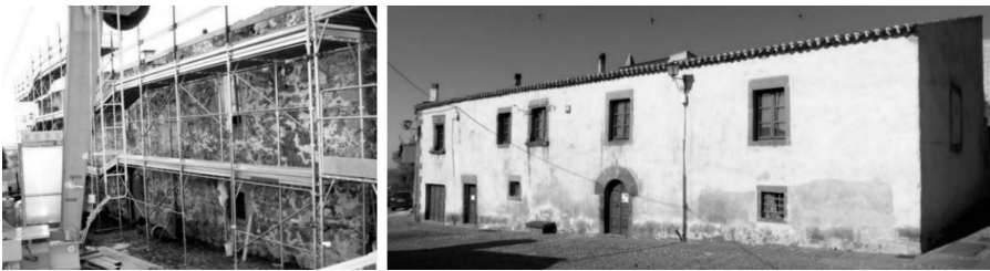
Figura 2. La casa Attene durante i lavori del 2007 e oggi.
