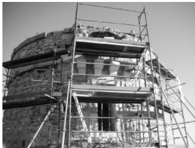
Figura 4. Vista de la reconstrucción del matacán y del acceso original a la Torre de Cala Teulera (A. Seguí)
