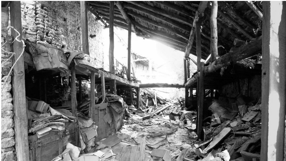
Figura 6. Recinto amurallado. Espacio interior de un adosamiento. Buitrago del Lozoya, Madrid. 2012.
