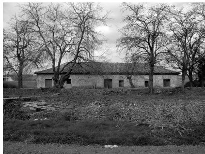
Figura 7. Casa de la Cuarta Esclusa, de 1830, ante el cauce del Canal. Febrero de 2008. Foto del autor.
