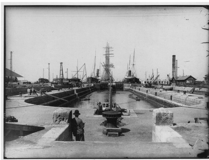
El dique de Matagorda y su entorno en 1878
