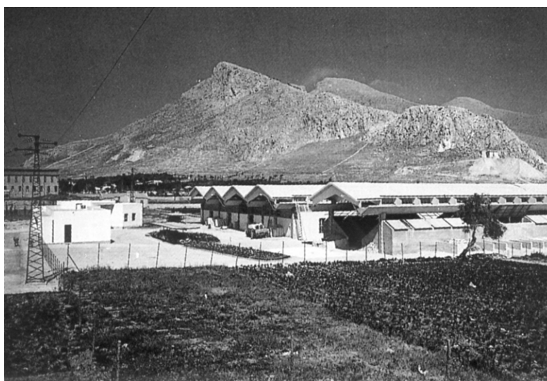
Veduta della fabbrica Cedis (AdM); sullo sfondo a sinistra lo stabilimento della Montedison.
