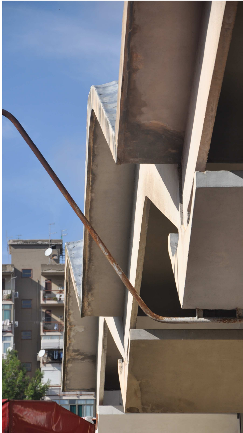
Particolare prospetto sud-ovest, 2010
