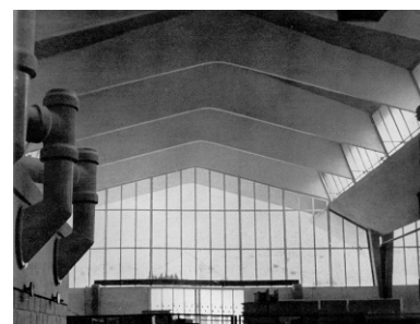
Dall'alto: dettaglio del prospetto laterale sud-ovest ed esploso assometrico, ridisegno 2010 (vedi Vol. III, tav. A8.2); foto del prospetto sud-ovest a cantiere ultimato, veduta esterna ed interna.
