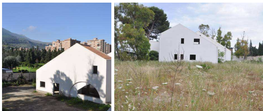
Residenze. Da sinistra: 1. Veduta del fronte sud-est dagli uffici dell'ex complesso Icem; 2. Fronte nord-ovest
