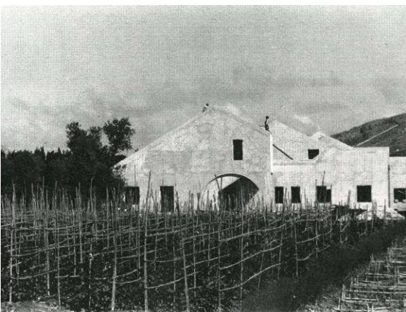
Case per i dipendenti. Dall'alto: 1. Schema delle cellule abitative, piano primo e piano terra, ridisegno, 2010 (vedi VOL.III – tav A4); 2. Foto del cantiere in corso d'opera, fronte sud-ovest (AdM); 3. Foto a cantiere ultimato, fronte nord-est (AdM)
