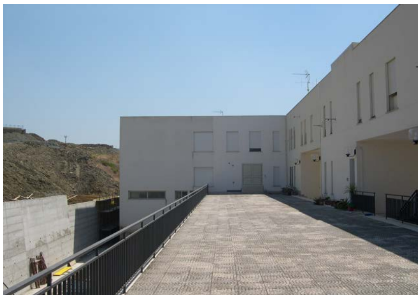
Vista della passeggiata sopraelevata dopo la realizzazione del muro di contenimento
