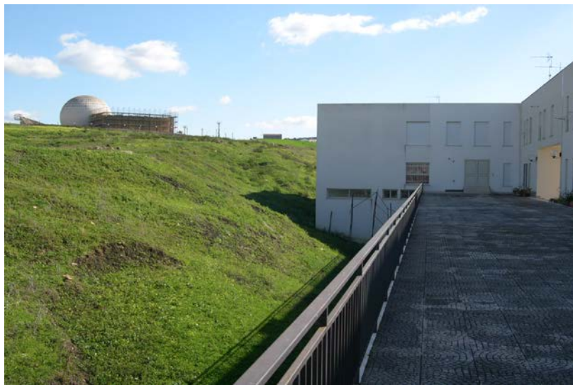
Vista della passeggiata sopraelevata prima della costruzione del muro di contenimento
