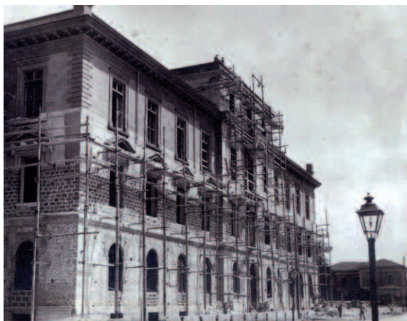
Fig. 4: Il fronte rivolto su via Archirafi dell'Istituto di Fisica in costruzione, 1930-34, tratto da P. Barbera, M. Giuffrè (a cura di), Op. cit. , 2005.
