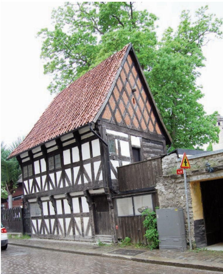
Figg. 1,2 - Differenti tecniche murarie come conseguenza del modello costruttivo tettonico e stereotomico: edifici nell'isola di Gotland, Svezia (foto M. L. Germanà 2010).
