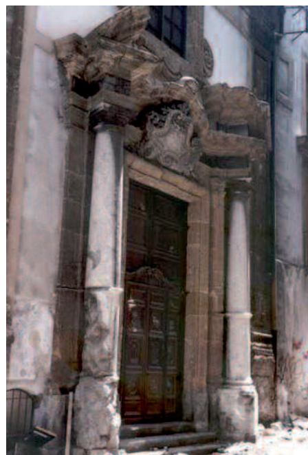
Fig. 7: Palermo, Chiesa dei Tre Re, portale in conci di calcarenite a grana media e stucchi in pessimo stato di conservazione (R.M. Vitrano).
