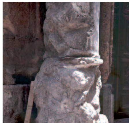
Fig. 8: Analisi dello stato di conservazione - Portale della Chiesa dei Tre Re, particolare della colonna in calcare bianco siciliano e all'appoggio piedistallo in marmo di billemi, (R.M. Vitrano).
