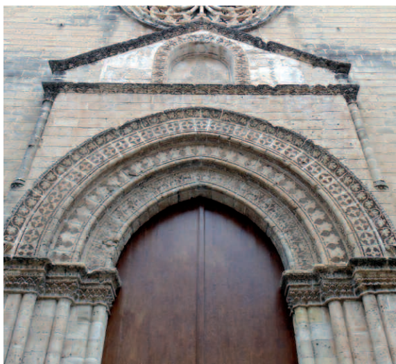
Fig. 6: Palermo, Chiesa di Sant'Agostino, particolare del coronamento del portale, con tarsie in calcarenite giallastra e pomice vulcanica nera (G. Castrovinci).
