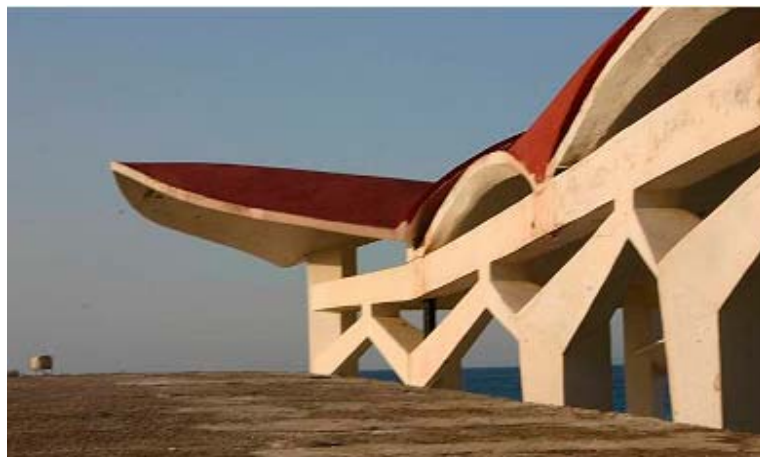
Dettaglio della copertura d'ingresso
