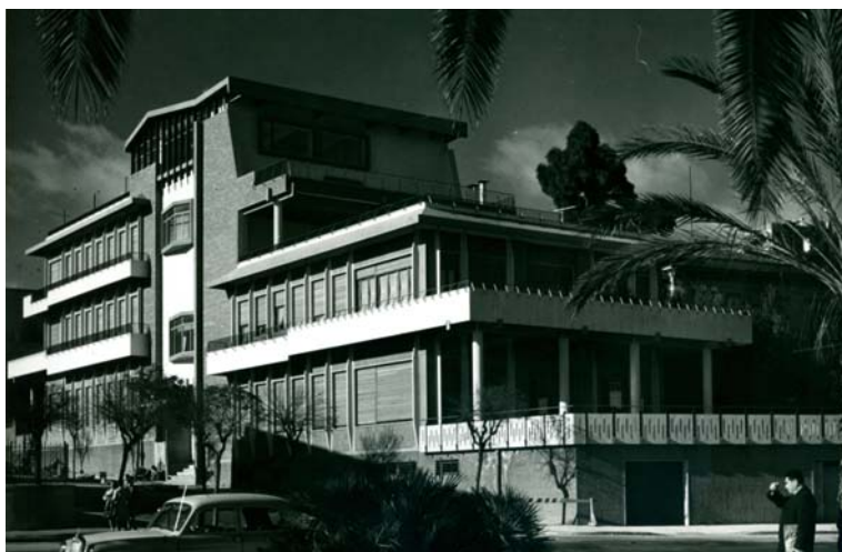
Vista della casa Ballo da Viale libertà. Prospetto lato mare
