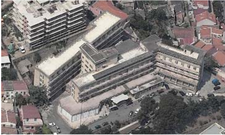
Vista aerea dello stato attuale dell'edificio
