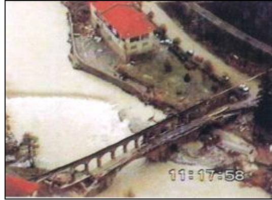
Fig. 2.2.3 Bagnasco. Classico esempio di manomissione dell'alveo di un fiume: sono state interrato due arcate di un antico ponte romano e, dietro una di queste, la superficie ricavata è stata utilizzata per edificare un immobile.
