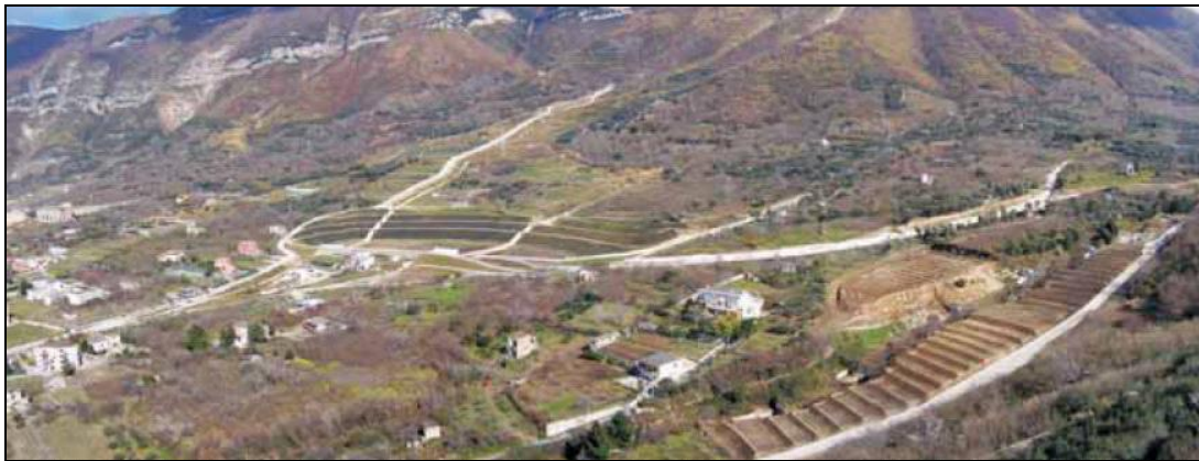
Fig. 2.3.4 Sarno. Foto aerea delle opere di difesa dell'abitato. Si notano i canali e la vasca di accumulo
