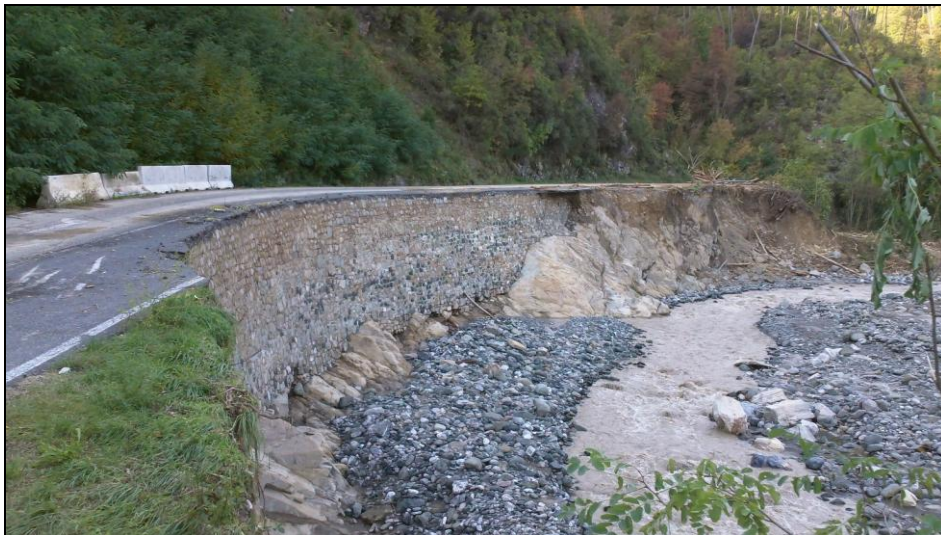
Fig. 2.4.4 Ponente ligure. Una frana ha portato via il rilevato stradale di un ampliamento di una strada portando alla luce la precedente struttura che è rimasta intatta
