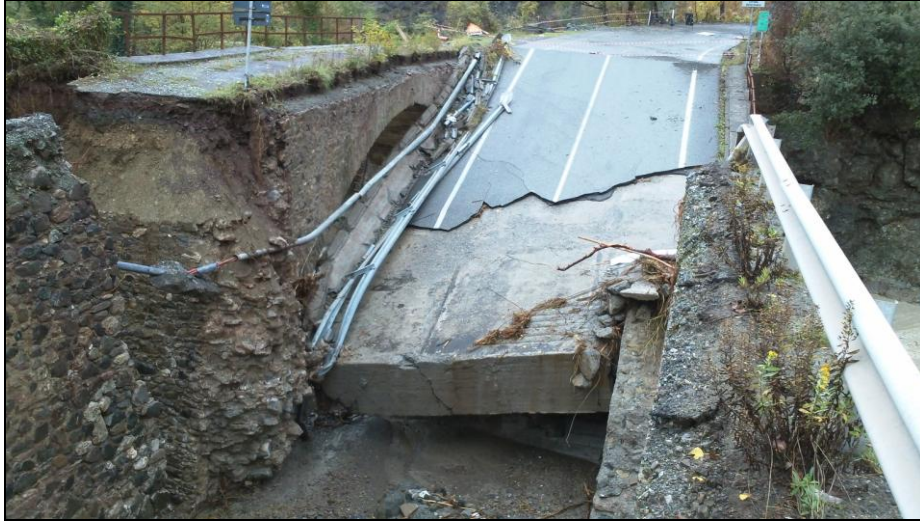
Fig. 2.4.3 Ponte ligure. Il crollo per la piena dell'ampliamento di un ponte ha portato alla luce la precedente struttura medievale che è rimasta intatta
