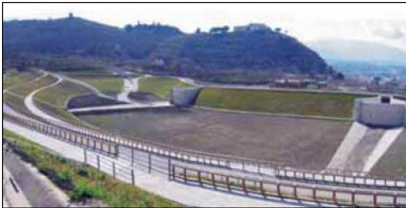
Fig. 2.3.6 Sarno. Particolare della vasca di accumulo
