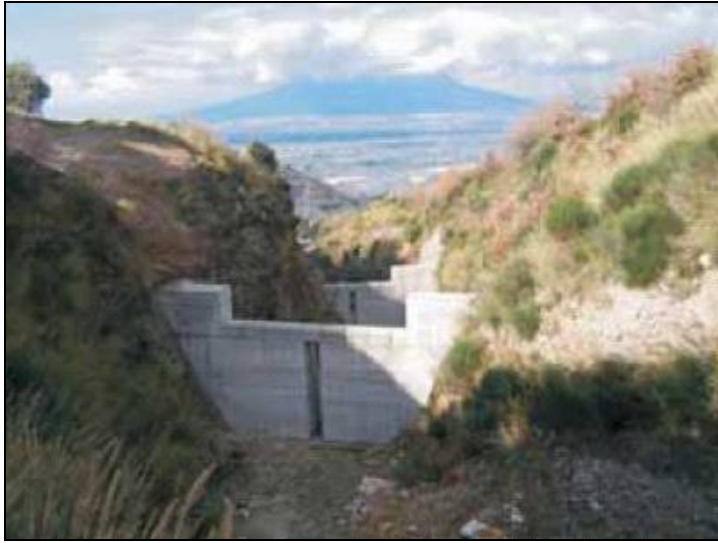
Fig. 2.3.3 Sarno. Briglie lungo i canali di scolo lungo gli impluvi
