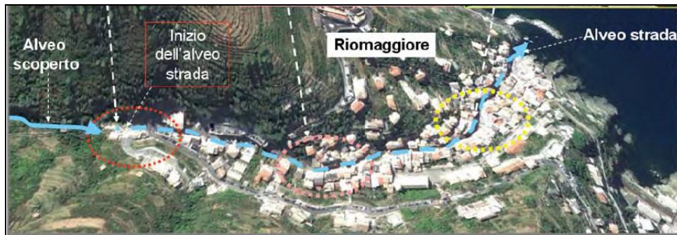
Fig. 2.4.2 Riomaggiore. Rappresentazione grafica delle condizioni di rischio idrogeologico. Tratto da “L’evento alluvionale del 4 novembre 2011 a Genova”, in Geologia dell’ambiente, supplemento al n.4
