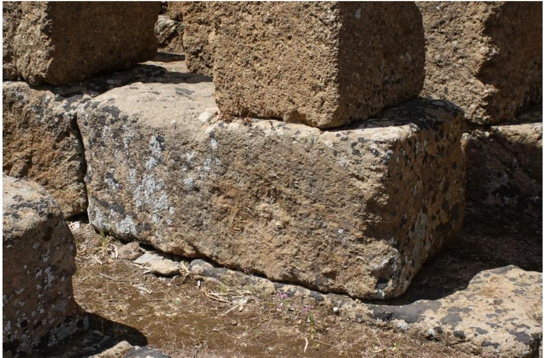
*Fig. 3.4.13 - In alto: sovrapposizione dei blocchi delle basi (2010).*
