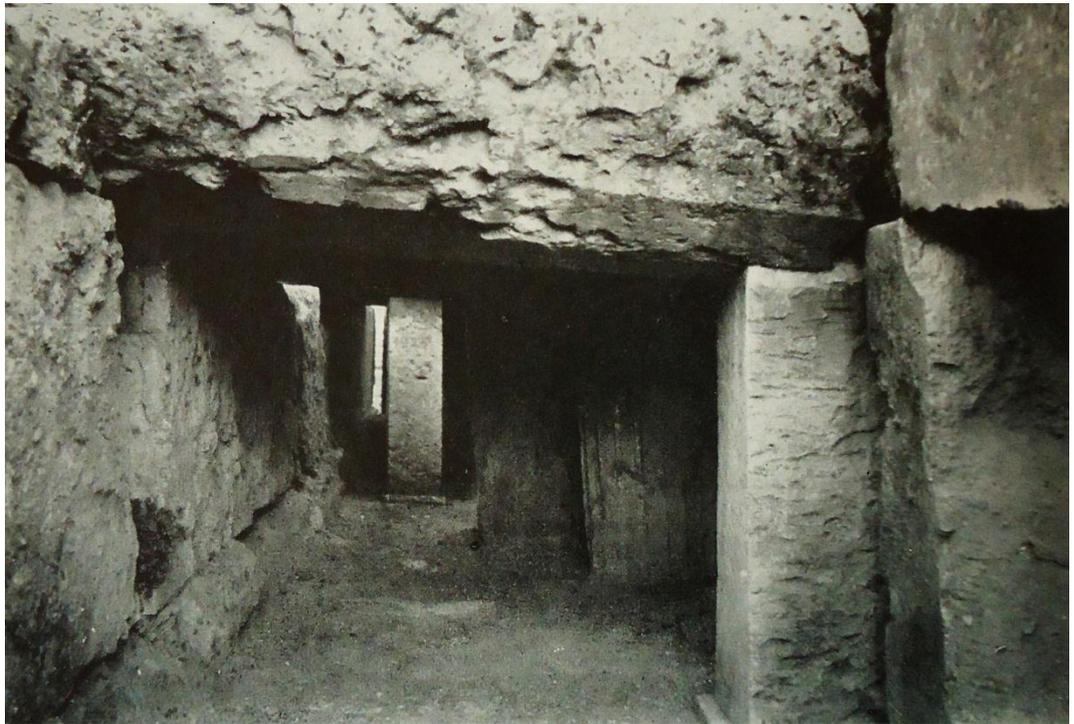
*Fig. 3.4.25 - In alto: Il sistema costruttivo a piedritto architravato, nel vespaio della cella dell'Apollónion, con riempimento di terra frammista a carboni; scavo 1917 (da L. Pernier, 1935).*
