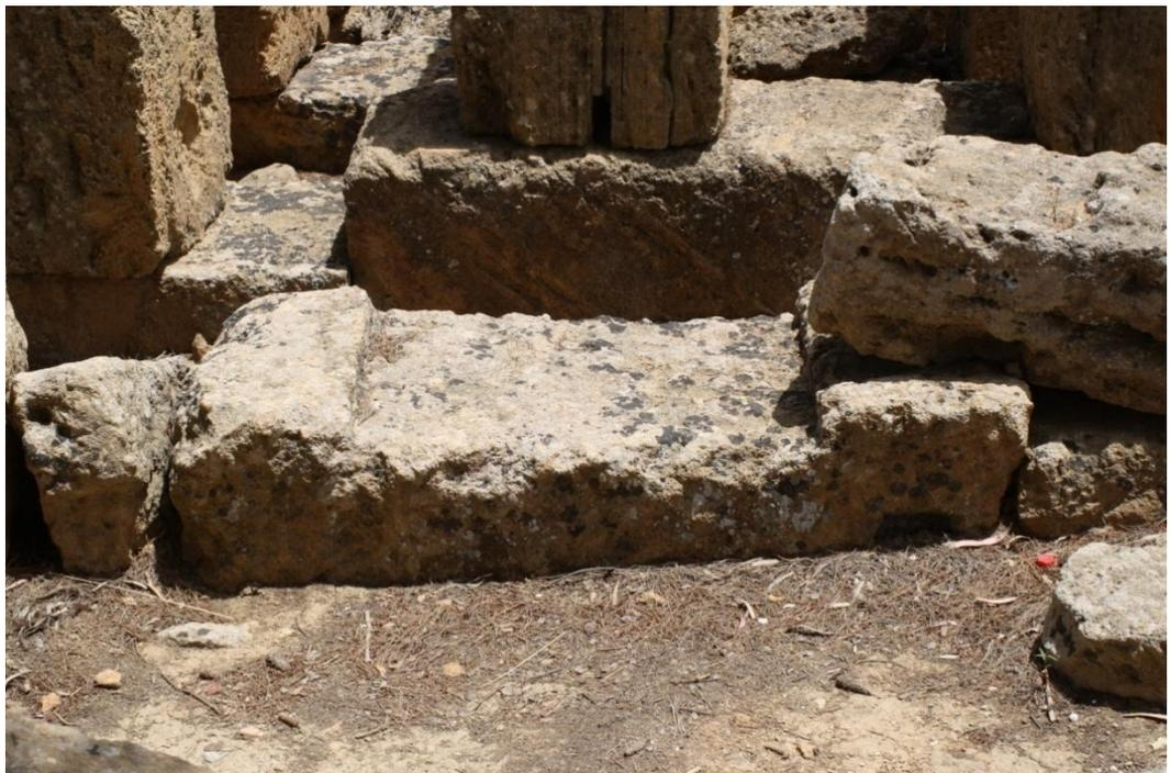
*Fig. 3.2.7 - In alto: l'euthyntéria praticata direttamente in cantiere sui filari delle basi. Nel filare intermedio si vede l'incisione da foro di leva, necessaria per il sollevamento del piedritto (2010).*
