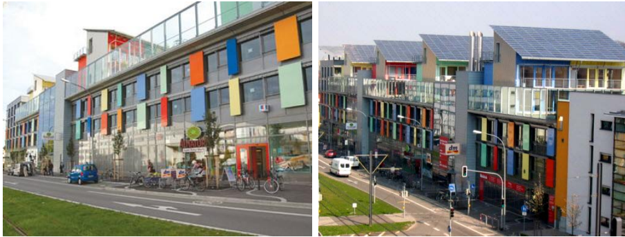
Fig. 10.9 a-b Sonnenschiff Centre in Freiburg (Germany).
