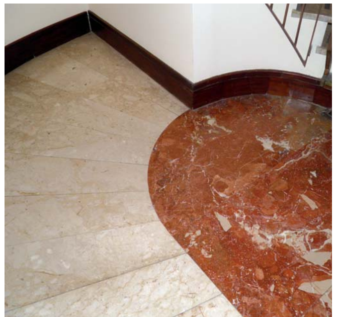
Fig. 13. Palermo. Grand Hotel Villa Igea all'Acquasanta, dettaglio della scala con lastre di perlato in bicromia con il rosso Montecitorio (fotografia LapiS).
