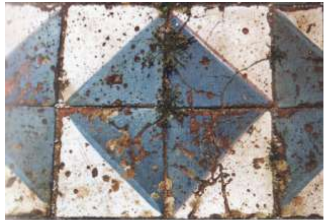
21/ Particolare della pavimentazione della terrazza belvedere
