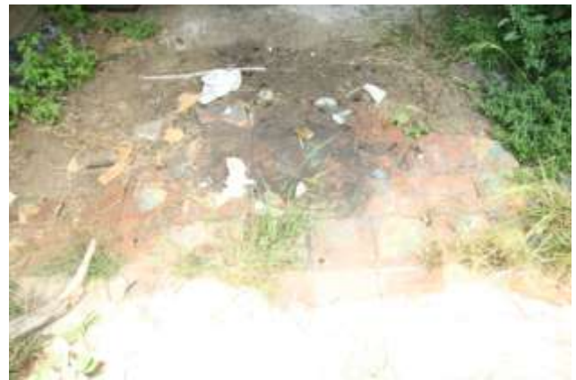
25/ Particolare della pavimentazione del Coffee House
