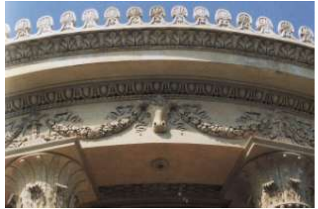
40/ Coffee House in stile neo pompeiano, dopo gli ultimi restauri ( particolare )
