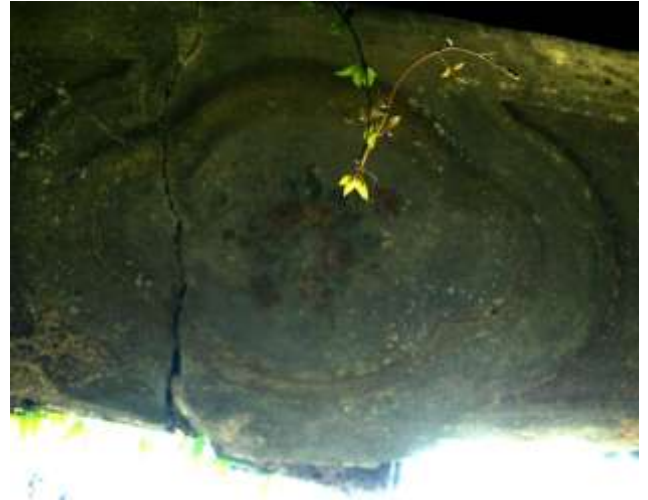
27/ Particolare dell'intradosso dell'arco di ingresso in una foto odierna
