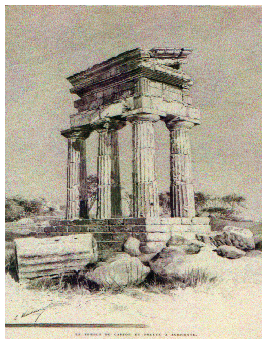
8/ Dopo il 1842 il tempio per problemi di natura statica è oggetto di una nuova operazione di anastilosi che aggiunge una quarta colonna.
