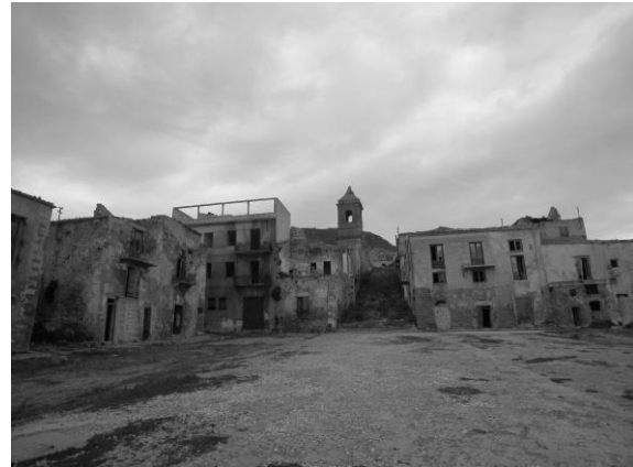
Fig. 8: Poggioreale. Piazza Sant'Elimo oggi, fronte nord, con i danni del terremoto (foto dell'autrice).
