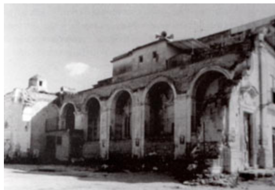
Fig. 11: Menfi. Chiesa madre, ruderi dopo il terremoto [Mistretta 1996].
