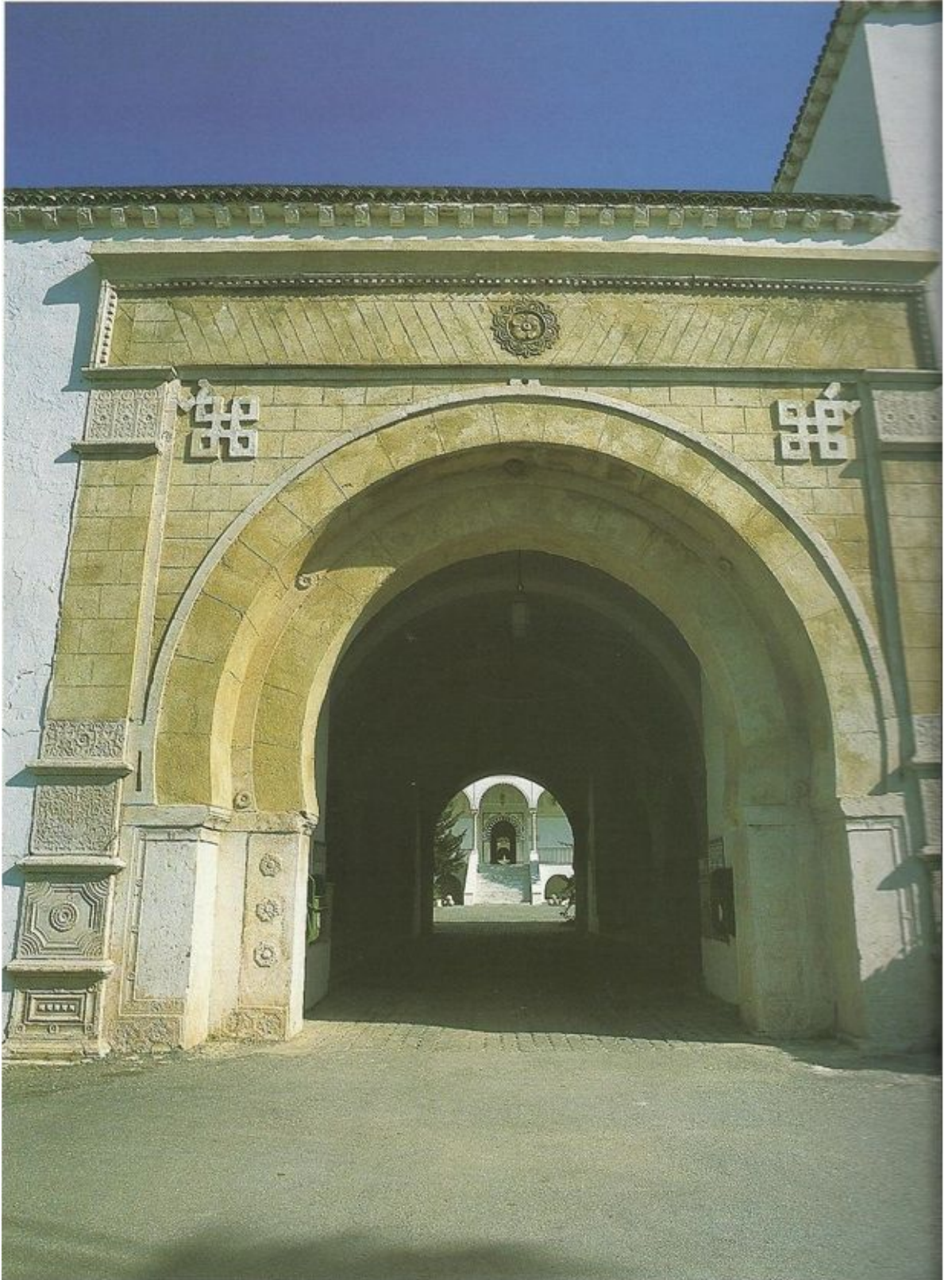
Fig. 9 Passaggio arcato del palazzo della Rosa.
