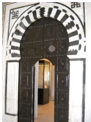
Fig. 7 Il marmo nero della porta d'ingresso della sala di giustizia.
