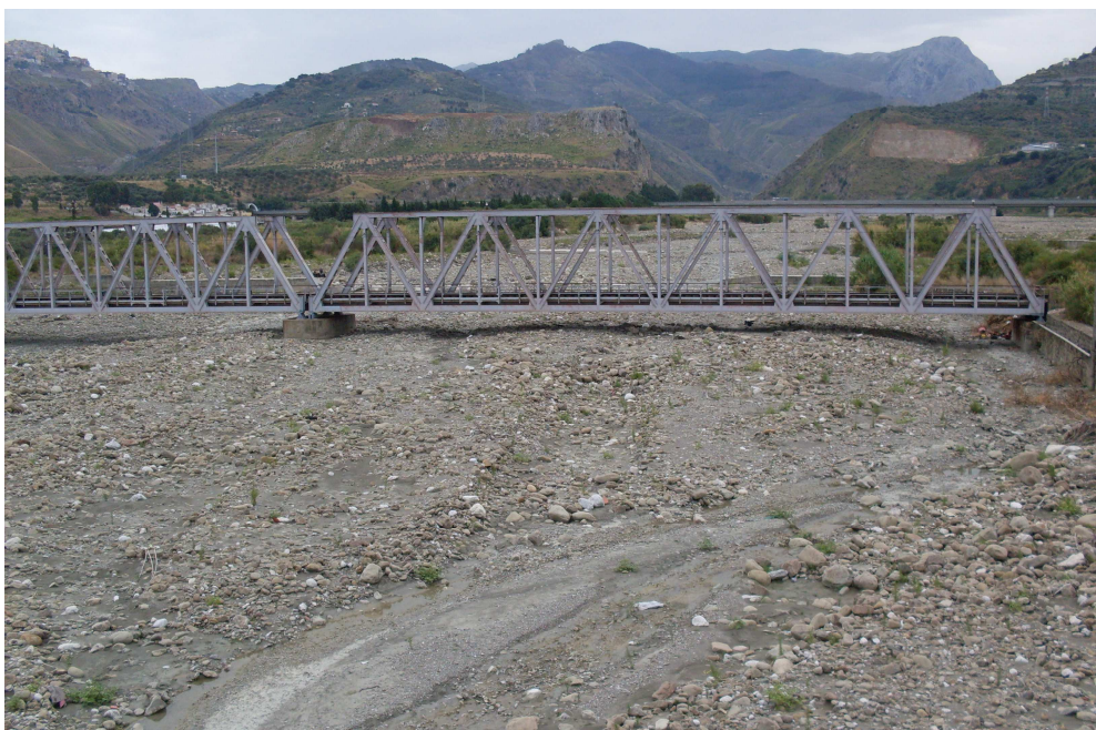
Fig.18 – Depositi alluvionali recenti e depositi di piana litorale del Torrente Rosmarino
