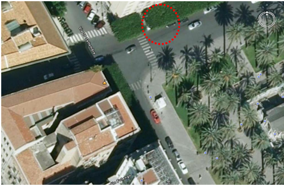
Figura 7.9 – Cabina di rilevamento “Castelnuovo” della rete AMIA di Palermo (Fonte: Google Earth)
