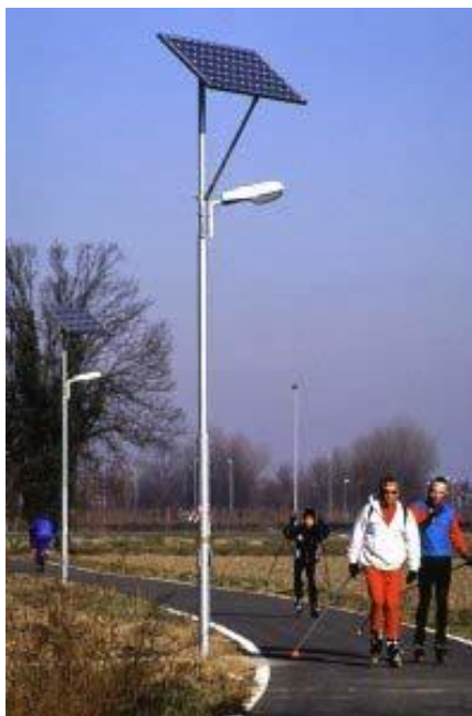
Figura 3.9 Lampioni a pannelli solari su pista ciclopedonale
